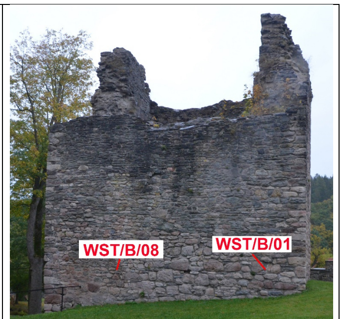
Abbildung 2: Westseite des Turmstumpfes mit Lokalisierung der Probenahmestellen
