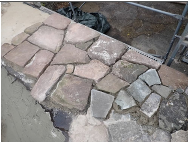
Abbildung 86: Aufmauern der Mauerkrone
