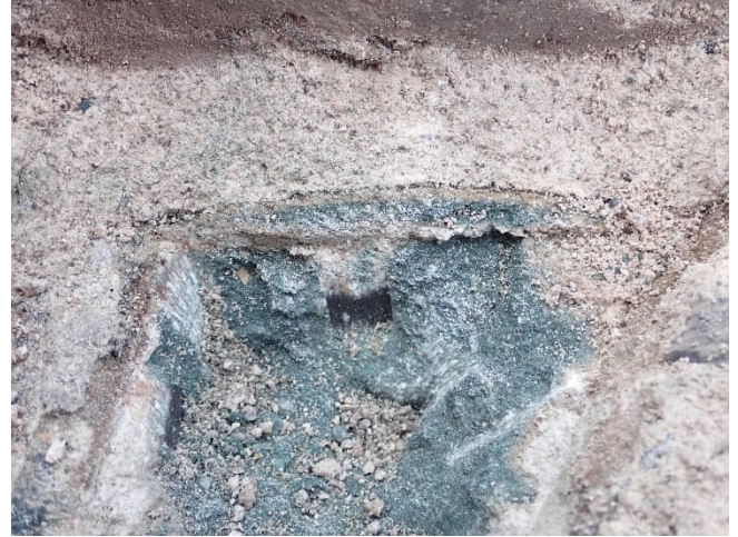
Abbildung 99: Mauerwerksöffnung im Bereich der Mauerkrone Turmstumpf: Die flächige Entkopplungsschicht ist intakt und in gutem Verbund (Pfeil), die Blaufärbung des darunter befindlichen Unterbaumörtels resultiert aus Bindemittelumwandlungen (Polysulfidbildungen)
