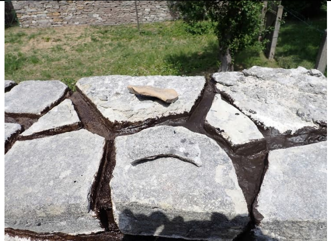
Abbildung 96: Auftrag der Abdichtungs- und Entkopplungsschicht in den Stoßfugen der Mauerkronenabdeckung (Teilbereiche 1 und 2).
