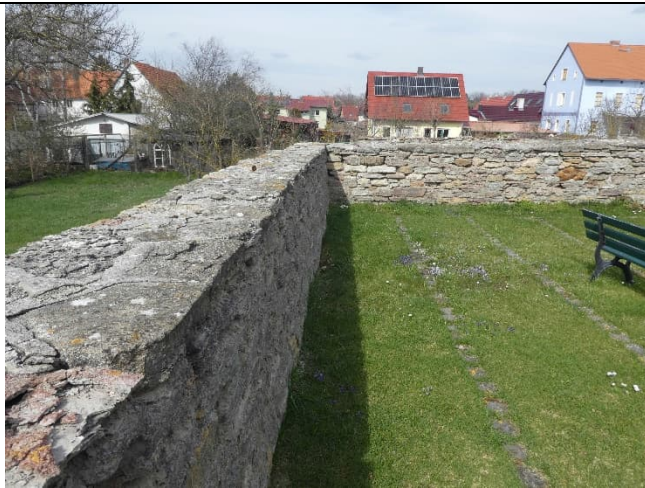
Abbildung 20: Teilansicht der Kirchhofmauer
