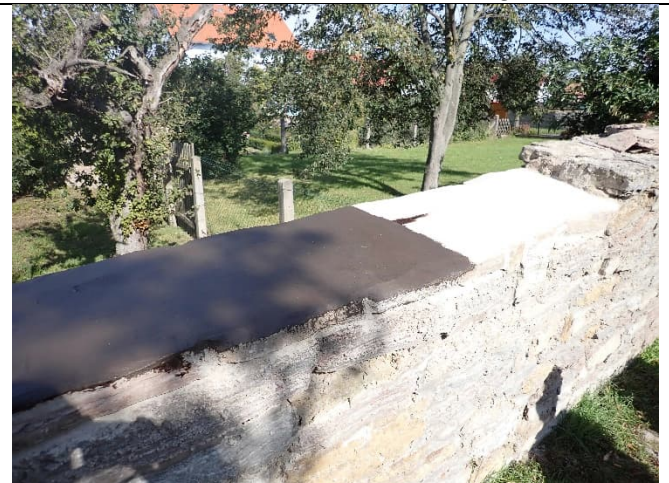
Abbildung 94: Auftrag der Abdichtungs- und Entkopplungsschicht (1. Auftrag mit reaktivem Füllstoff). Im Teilbereich rechts im Bild erfolgt eine Abdichtung in den Stoßfugen der Abdeckung.
