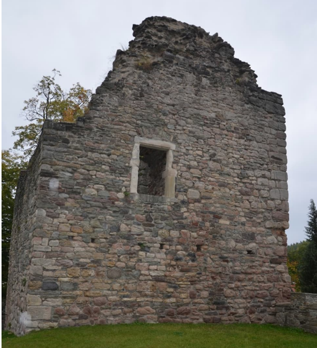
Abbildung 7: Turmstumpf, Ansicht von Südwesten
