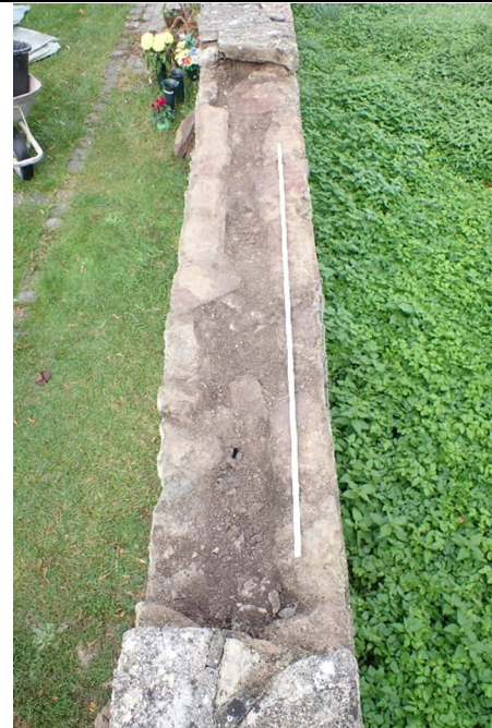
Abbildung 92: Oberseite Bestandsmauerwerk nach Abnahme der Mauerkronenabdeckung
