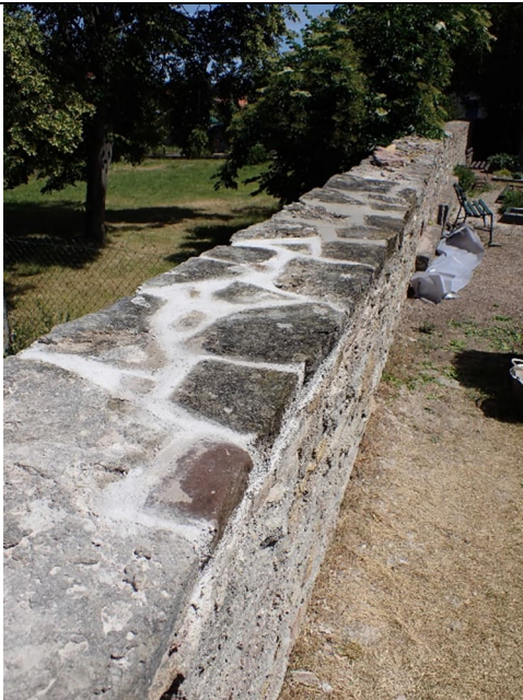
Abbildung 95: Aufmauern der Mauerkronenabdeckung
