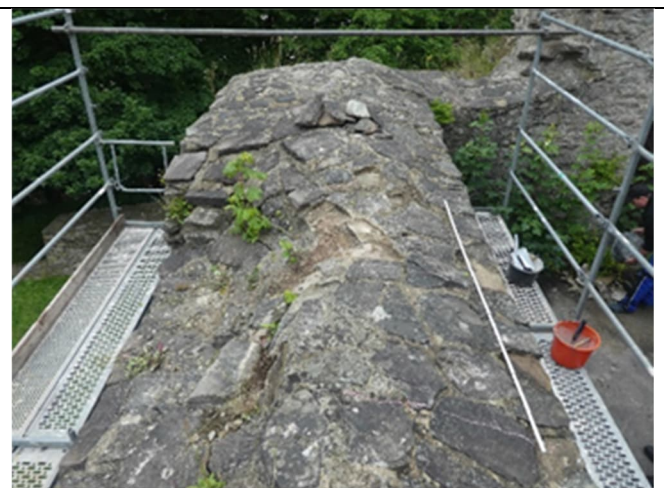
Abbildung 81: Mauerkrone im Bereich der anzulegenden Testfläche, Vorzustand
