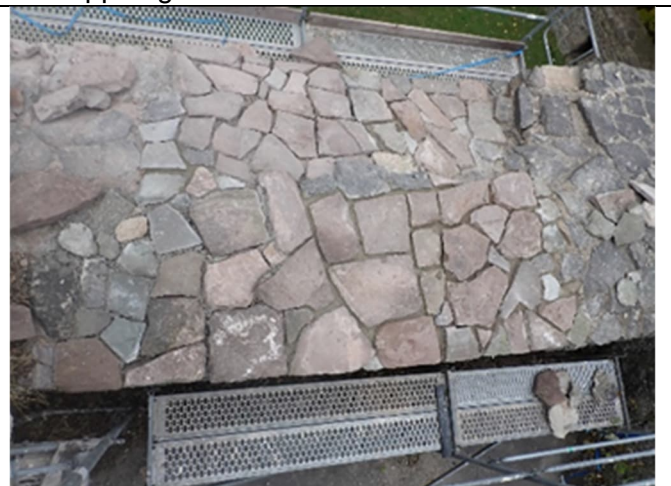
Abbildung 87: Fertig aufgemauerte Mauerkrone
