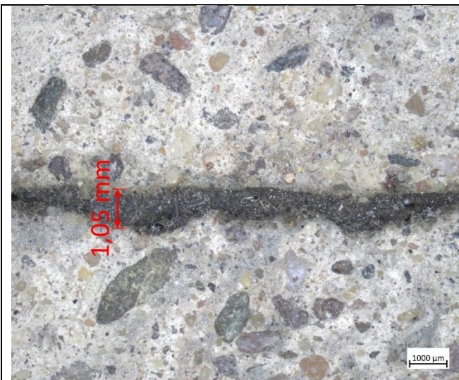
Abbildung 44: Verbundkörper A im Bereich der Dicht- und Entkopplungsschicht: Die Schichtdicke liegt im Bildausschnitt zwischen ca. 0,4 und 1,3 mm. Der Übergang von Abdichtungsschicht zum aufliegenden Mörtel ist scharf abgegrenzt und ohne Übergangszone. (Bildunterkante: 12,1 mm)
