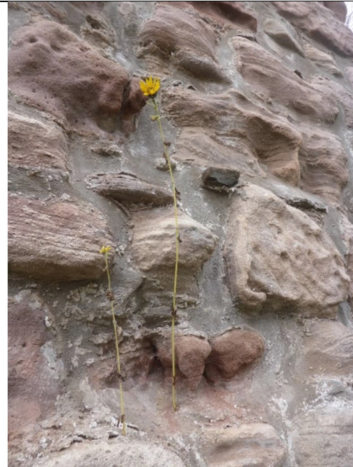
Abbildung 14: Nachträgliche Verfugung des Sandsteinmauerwerks mit einem dunklen hydraulischen Mörtel
