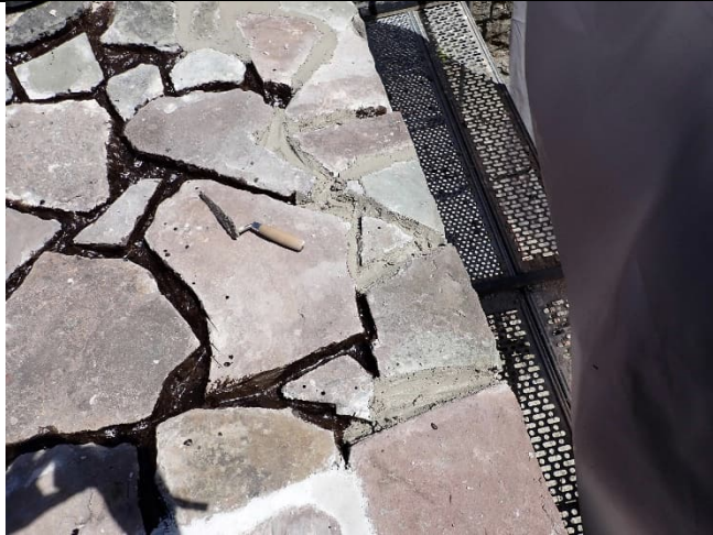
Abbildung 88: Einbringen der Entkopplungsschicht in die Stoßfugen der Mauerkronenabdeckung (4. Auftrag, links im Bild) und anschließende Verfugung
