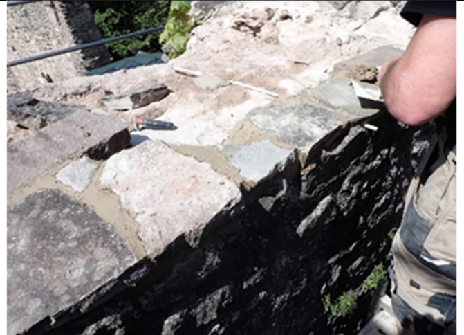
Abbildung 83: Aufmauern des Unterbaues für die Abdichtungs- und Entkopplungsschicht
