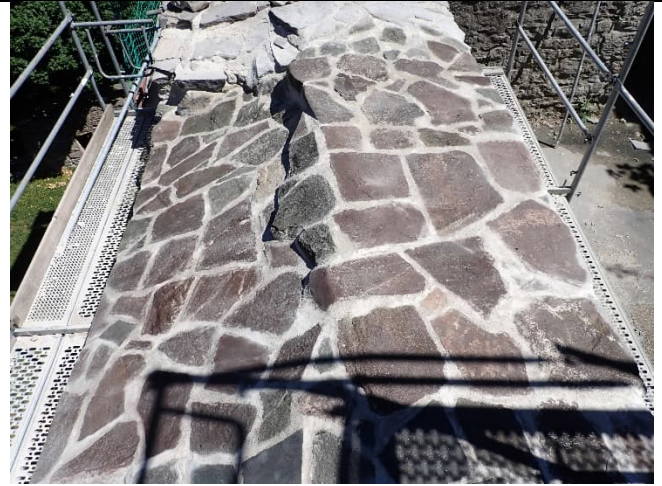
Abbildung 89: Fertig verfugte Mauerkrone
