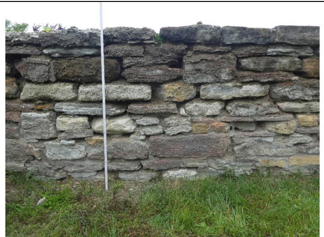
Abbildung 21: Detail der Mauer mit den stark ausgewaschenen Fugen
