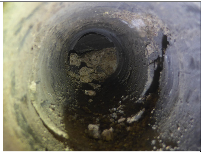
Abbildung 6: Kernbohrung WST/B/02, Bohrlochstirn nach Entnahme der Teilprobe WST/B/02.7 in 31 cm Bohrtiefe. Gut erkennbar ist der dunkle Verpressmörtel.
