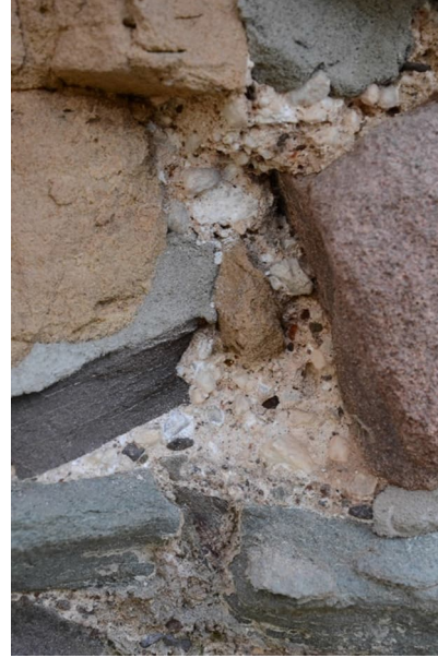
Abbildung 16: Nachträgliche Verfügung des Sandsteinmauerwerks mit einem dunklen hydraulischen Mörtel – hier in direktem Kontakt zu Gipsmörtel
