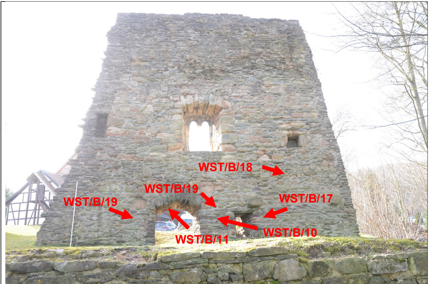
Abbildung 2: Mauerrest der Kapelle, Nordseite mit Lokalisierung der Probenahmestellen.
