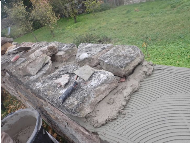
Abbildung 95: Aufmauern der Mauerkronenabdeckung
