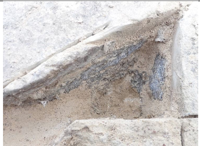
Abbildung 99: Mauerwerksöffnung im Bereich der Mauerkrone Turmstumpf: Die flächige Entkopplungsschicht ist intakt und in gutem Verbund (Pfeil), die Blaufärbung des darunter befindlichen Unterbaumörtels resultiert aus Bindemittelumwandlungen (Polysulfidbildungen)
