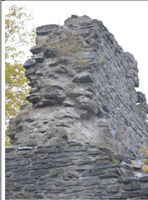
Abbildung 13: Sicherung des Mauerwerks des Turmstumpfes mit Spritzbeton
