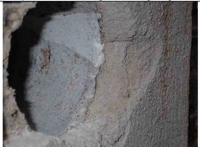
Abbildung 78: Bohrlochwandung im Bereich Kalksteinmauerwerksdemonstrator mit Gipsmörtelfuge / Entkopplungsschicht / Putzschicht ohne erkennbare Schäden oder Ablösungen
