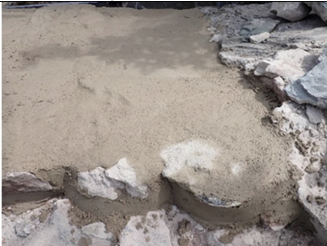
Abbildung 84: Mörtelabgleich auf dem Unterbau
