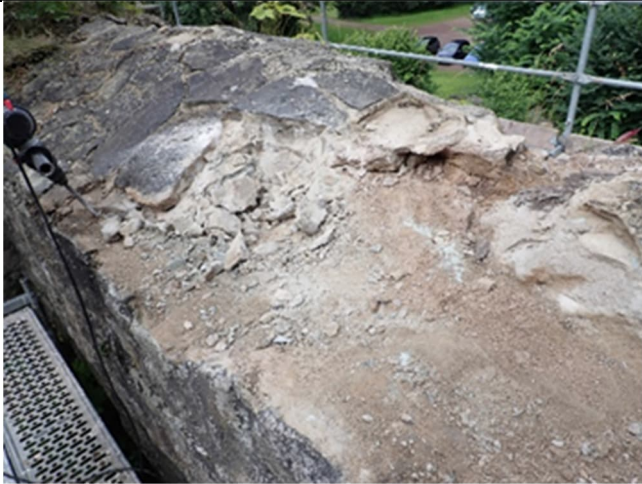
Abbildung 82: Abarbeiten der Mauerkrone im Bereich der anzulegenden Musterfläche
