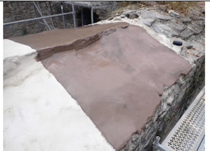
Abbildung 85: Aufbringen der Abdichtungs- und Entkopplungsschicht auf ca. 65 % der Fläche
