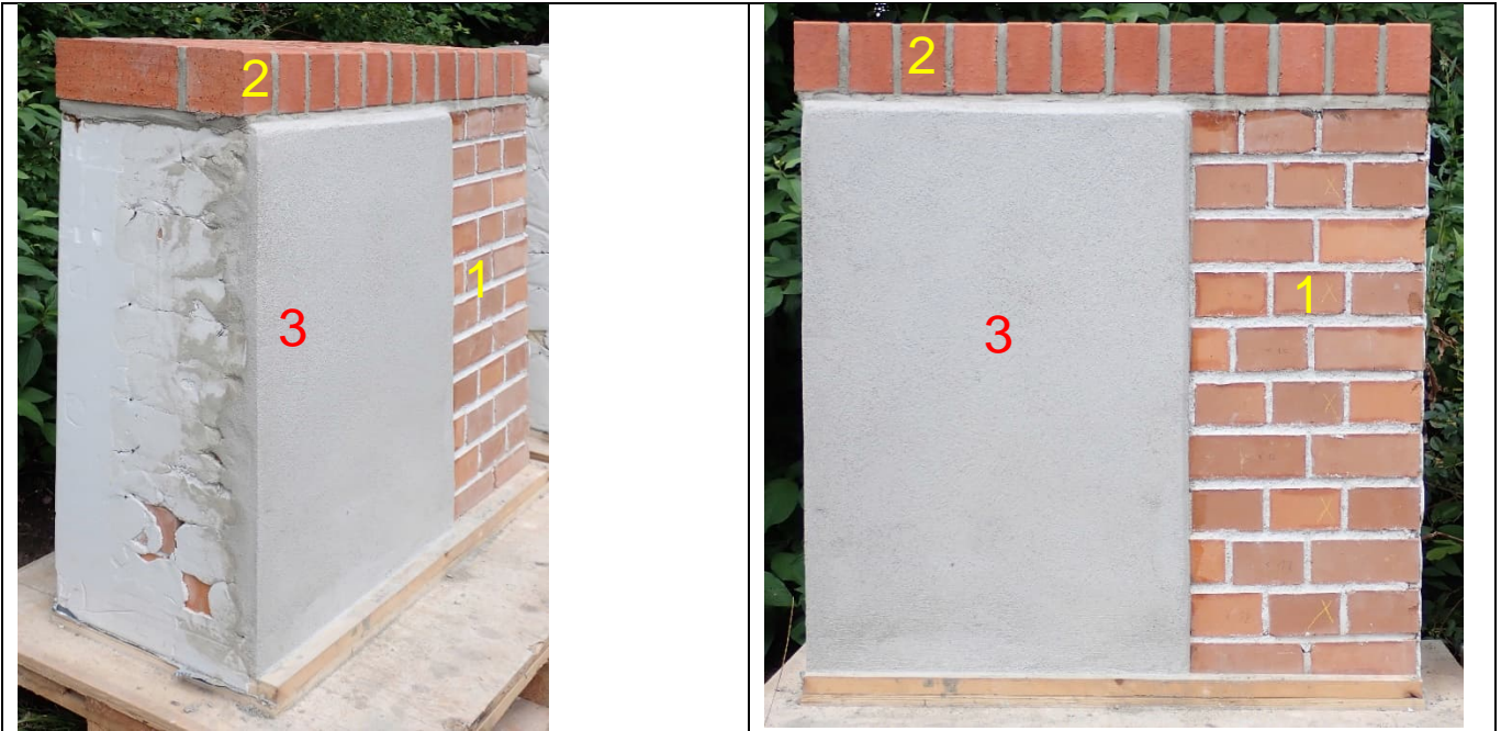
Abbildung 74: Mauerwerksdemonstrator, Ziegelmauerwerk, vor der Außenbewitterung 1 ... Ziegelmauerwerk, gemauert mit Gipsmörtel 2 ... Aufmauerung Mauerkrone, Klinkerrollschicht, gemauert mit Kalk-Zement-Mörtel, Entkopplung zum Ziegelmauerwerk durch WEBAC 5611 / tubag HSV-p 00 3 ... Verputz auf Ziegelmauerwerk, einlagig, hydraulischer Kalkputz, Entkopplung zum Ziegelmauerwerk durch WEBAC 5611 weiß / tubag HSV-p 00
