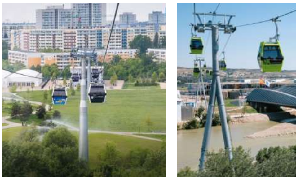
Abbildung 3.11: Übersicht Stützen; [Lei03]
