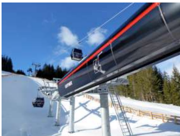
Abbildung 10.20: Zwischenstation mit einseitigem Ein- und Ausstieg [Ski21]
