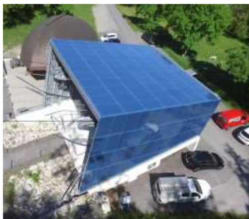
Abbildung 4.8: Talstation mit großflächiger Photovoltaikanlage [Senn23]
