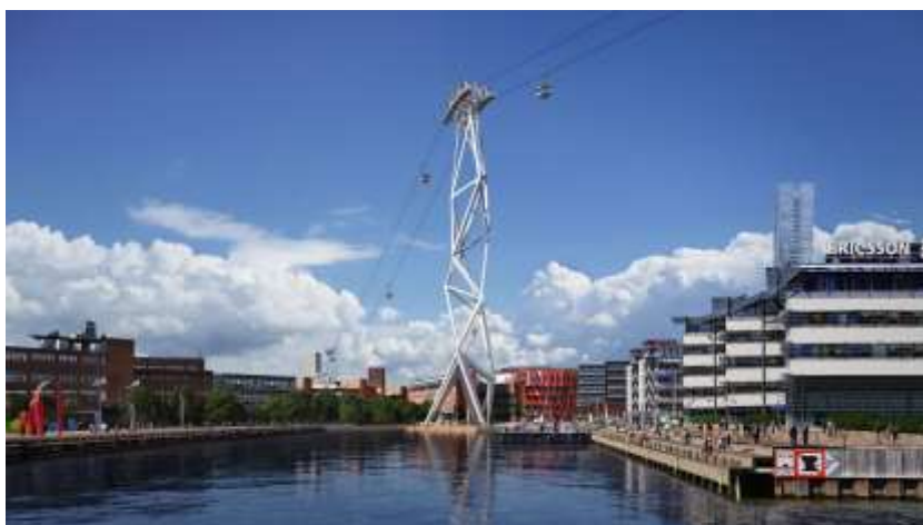
Abbildung 3.12: Konzept einer Fachwerkstütze der Seilbahn Göteborg [Plo23]
