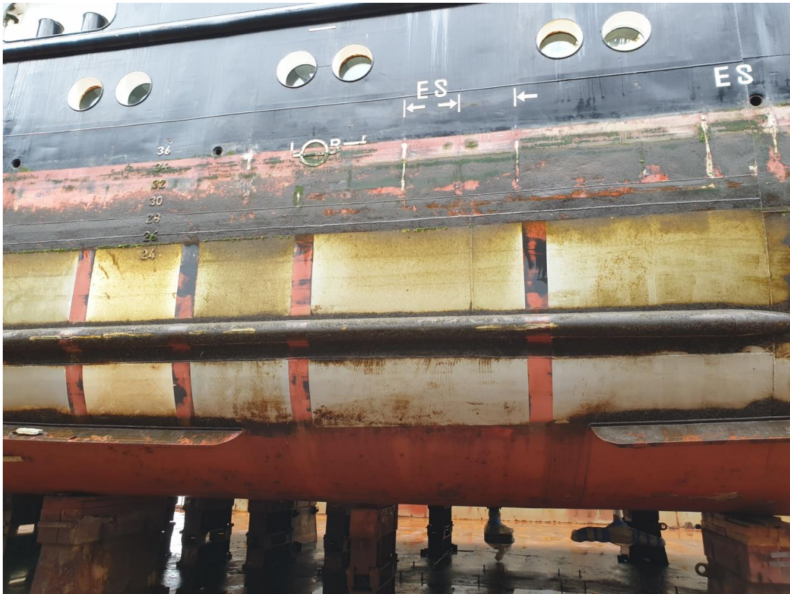
Abb. 30: Antihaft-Beschichtungen auf der „WEGA“ nach Unterwasserreinigung Juli 2019
