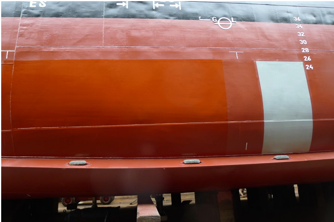
Abb. 14: Reinigungsfähige Testbeschichtungen auf der „WEGA“ nach Applikation November 2015
