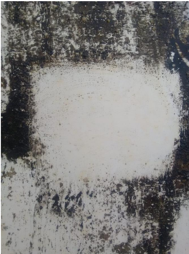
Abb. 45: Nahansicht gereinigte Fläche auf der Stahlplatte, November 2019
