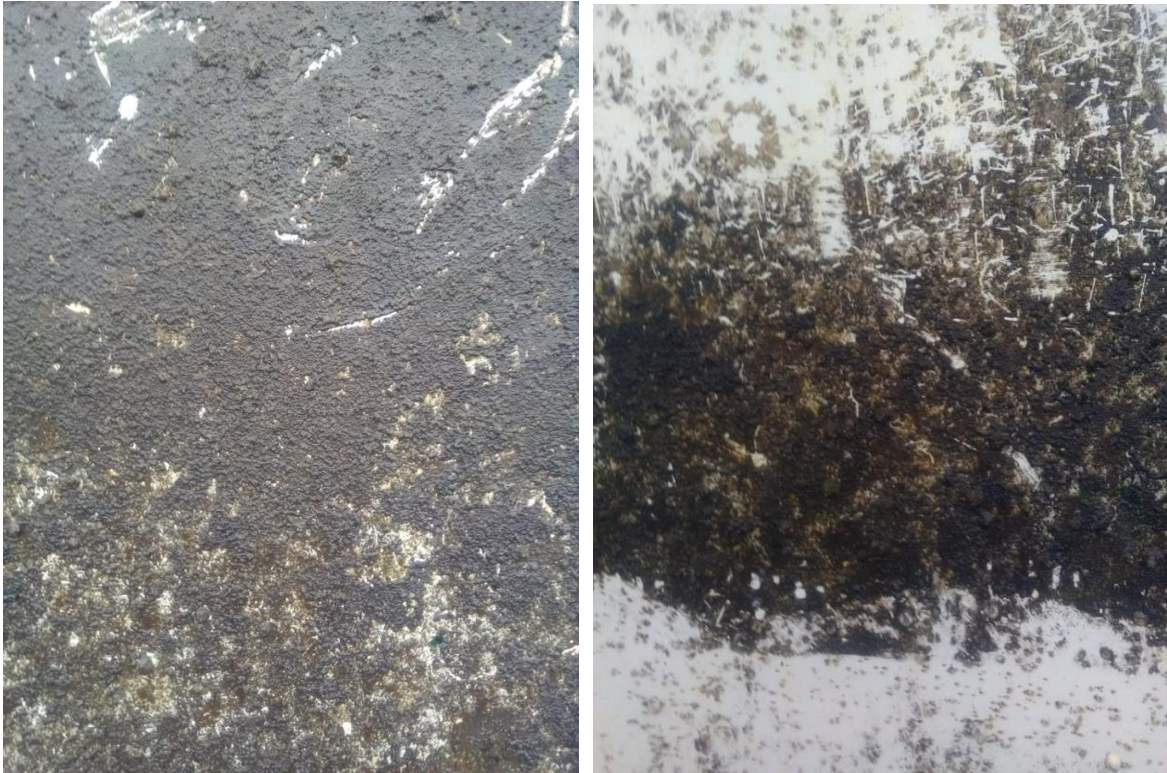
Abb. 42: Bewuchs auf Stahlplatte nach 7 Monaten Exposition an der Bredo-Werft Bremerhaven
