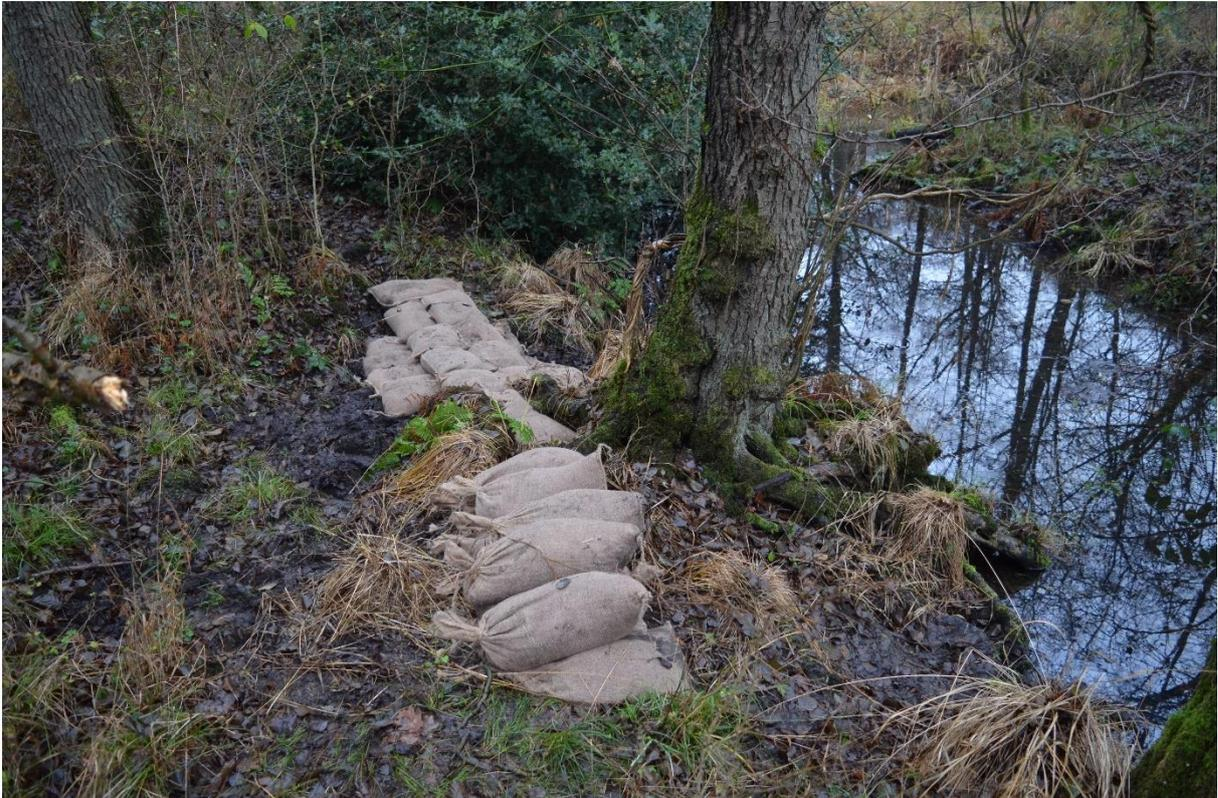
Abbildung 32: Sandsackdamm an einem Seitengraben des Grabens 1:21 (rechts) und Sandsacklager für spätere Ausbesserungen
