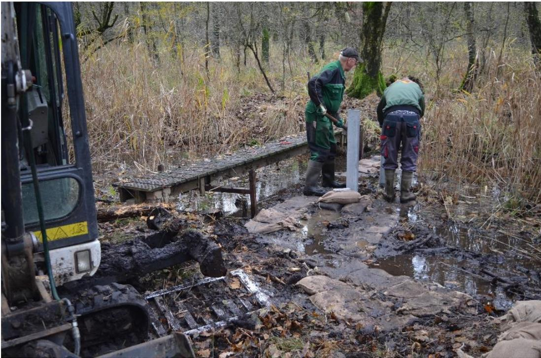
Abbildung 28: Bau des Dammes mit Überlaufschwelle im Nordosten (Graben 1.23)
