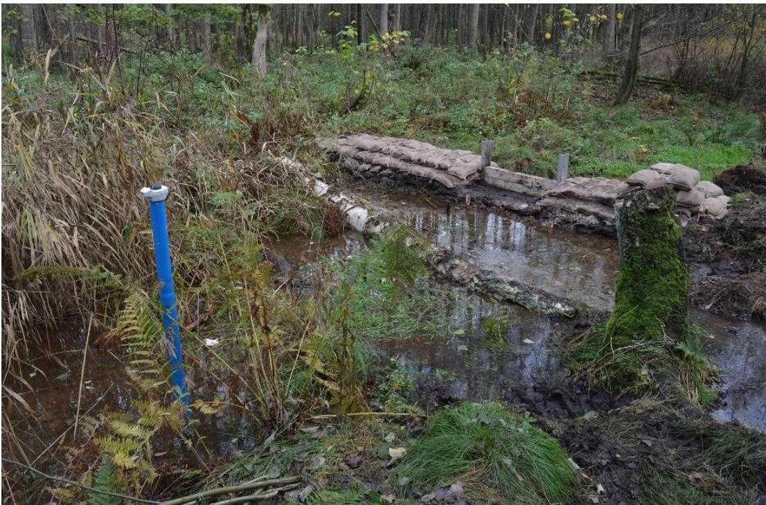
Abbildung 29: Fertiggestellter Damm mit Überlaufschwelle und Messstelle im Nordwesten (Graben 1.23)
