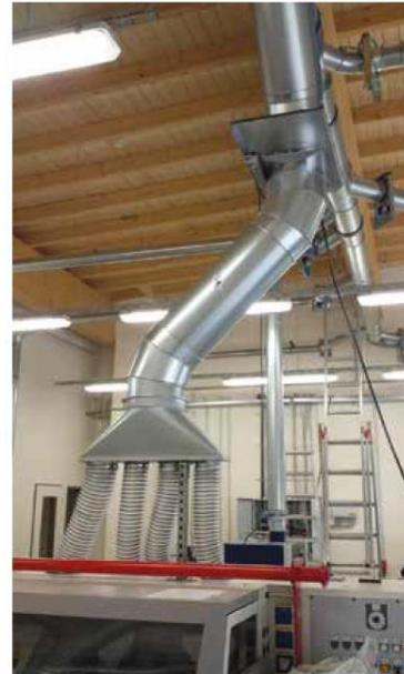
*Abbildung 12: Abluftabsauganlage mit Verrohrung*
