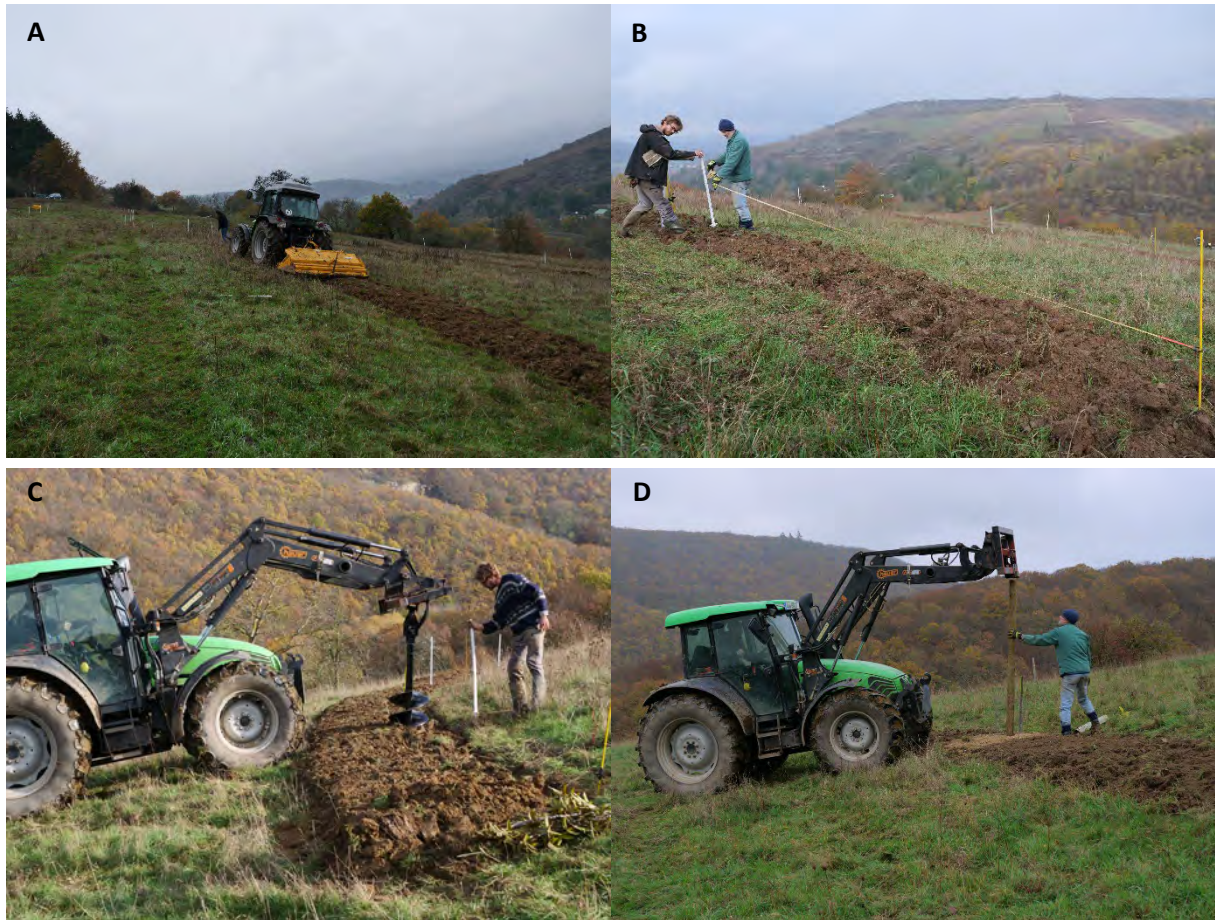
Abb. 23: A: Lockern der Baumstreifen mit der Spatenmaschine. B: Abstecken der Pflanzstellen. C: Bohren des Pflanzlochs. D: Setzen des Pflanzpfahls.
