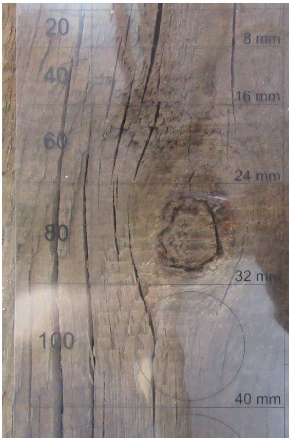
Abbildung 5 Balken mit Schablone für Sichtprüfung
