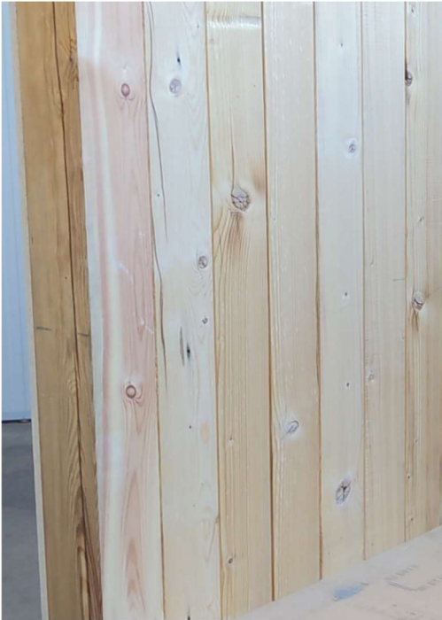
Abbildung 40 Kleinformatische nichttragende Außenwand ohne Dämmmaterial
