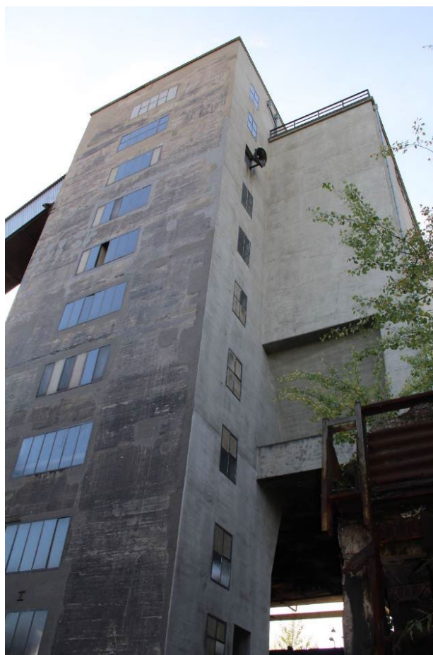
Abb. 50: Partiiell instandgesetzte Ostseite des Kohlenturms
