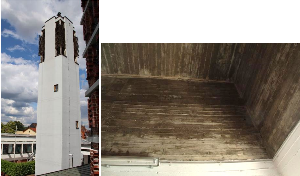
Abb. 7: Links: Außenansicht des freistehenden Glockenturms. Rechts: Die Innenansicht zeigt die original erhaltene Sichtbetonoberfläche mit Brettschalstruktur.
