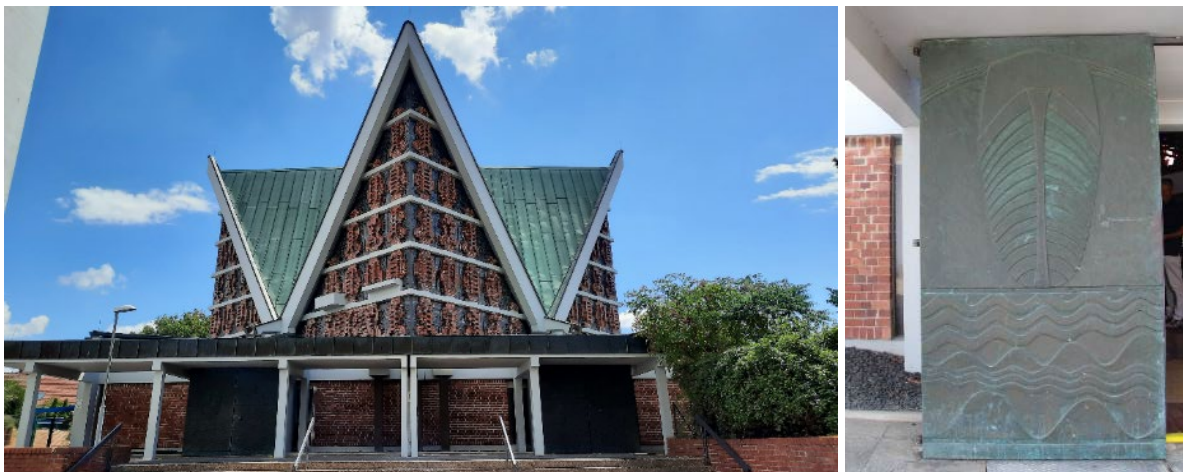
Abb. 6: Links: Nordansicht der evangelischen Christuskirche (Bingen-Büdesheim). Rechts: Detailaufnahme einer Bronzetür des linken Portals.
