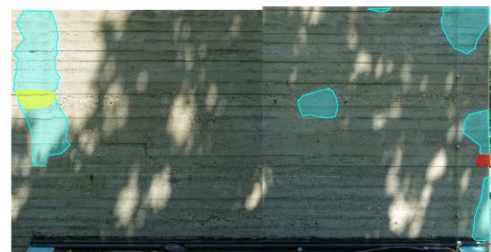
Ansicht Ost Dach
