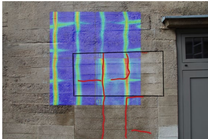
Abb. 25: Auf den Sichtbeton projiziertes Radargramm an einem repräsentativen Bereich der Südfassade. Die roten Linien kennzeichnen Risse. Der instandgesetzte Bereich ist schwarz umrandet.
