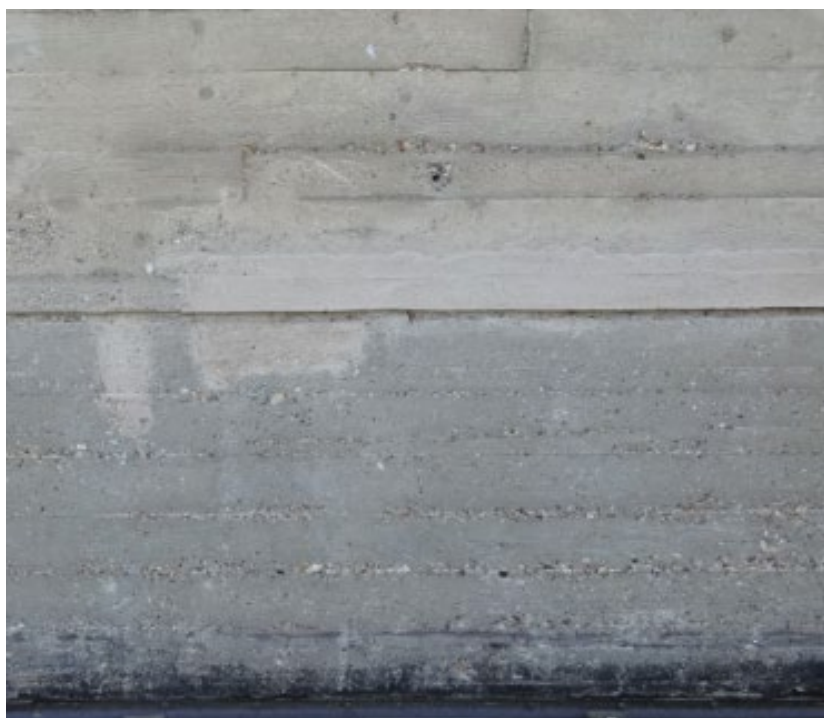
Abb. 37: Sehr gute farbliche Anpassung des Reparaturmörtels an den Bestandsbeton des oberen Betonierabschnitts, jedoch deutlicher Unterschied zum Bestandsbeton des unteren, etwas dunkleren Abschnitts (Zentralbau, Dach, Nordfassade).
