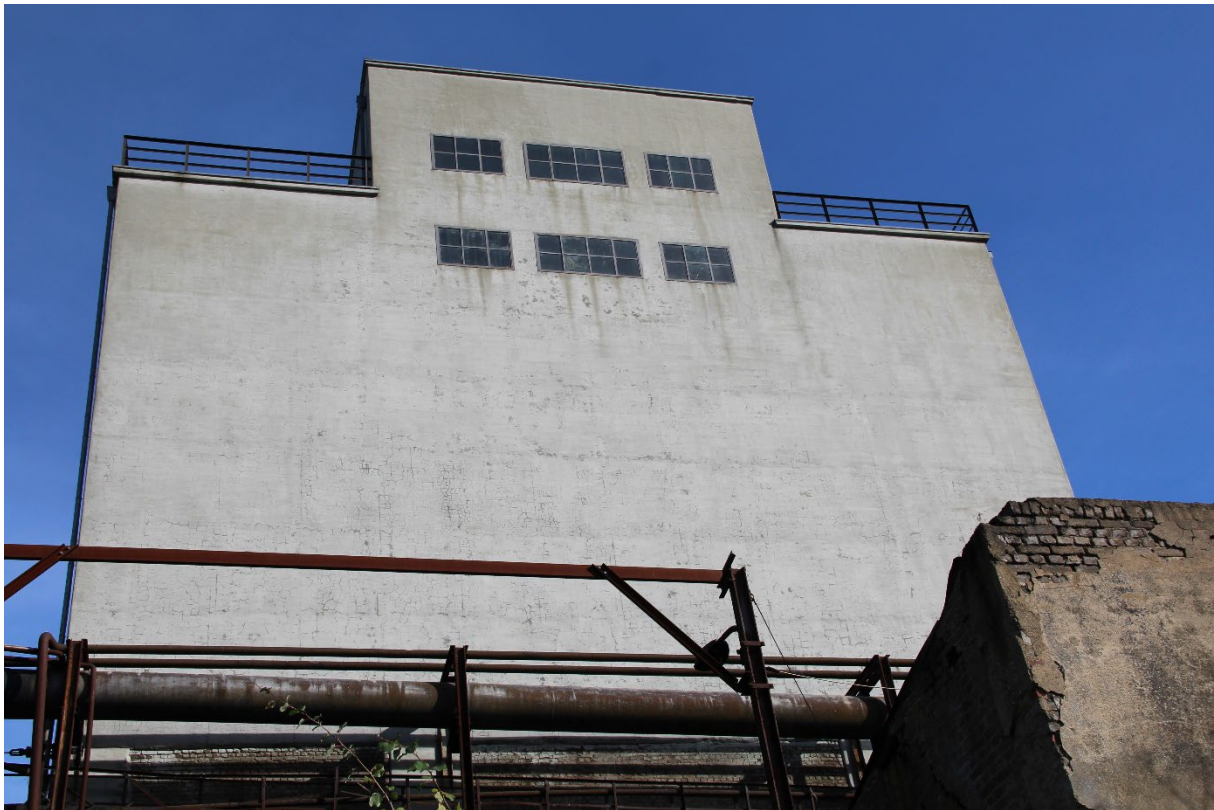
Abb. 49: Südfassade des Kohlenturms
