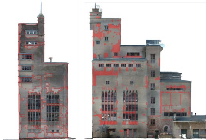
Abb. 21: Links: Kartierung der Instandsetzungsflächen an der Westfassade und Rechts: Instandsetzungsflächen an der Südfassade (rechts)
