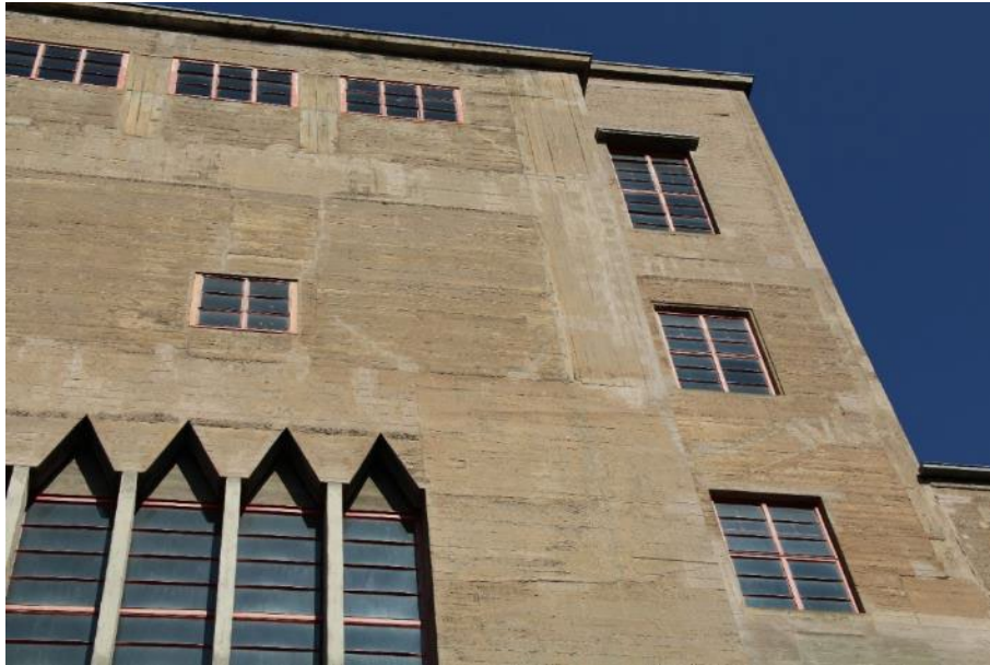
Abb. 18: Südfassade des Beckerturms
