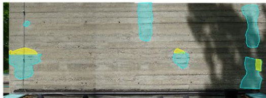
Ansicht West Dach
