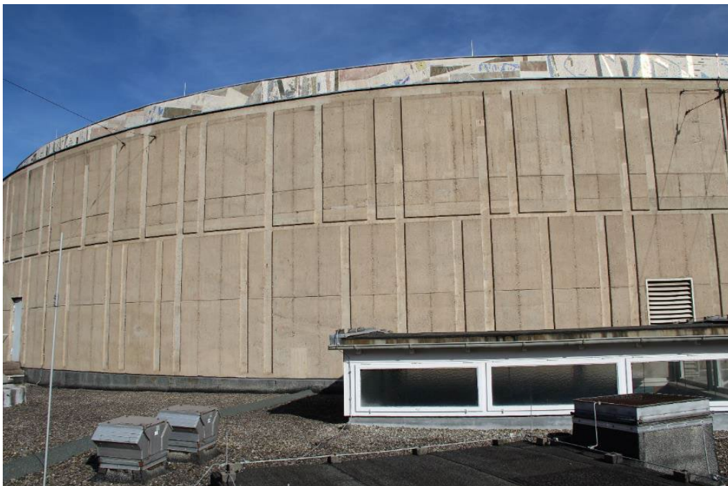
Abb. 57: Blick auf einen Ausschnitt der hufeisenförmig gekrümmten Außenwand des Beethovensaals mit charakteristischer Felderung und leicht aufgehellten Instandsetzungsstellen.
