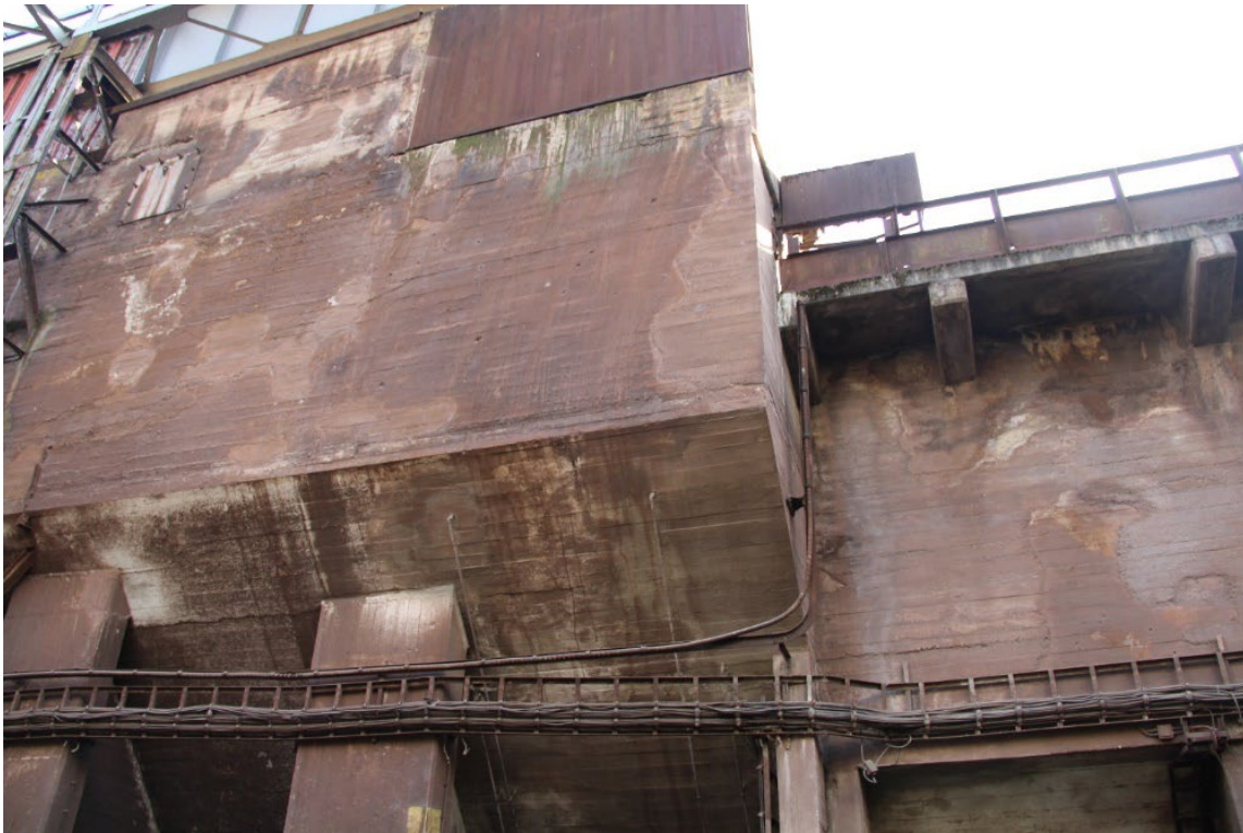
Abb. 48: Foto des Rohstoffbunkers, Zustand 2022.
