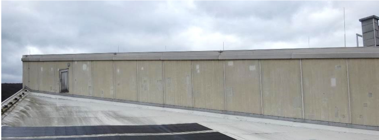
Abb. 71: Teil des Untersuchungsbereichs auf dem Dach der Stadthalle
