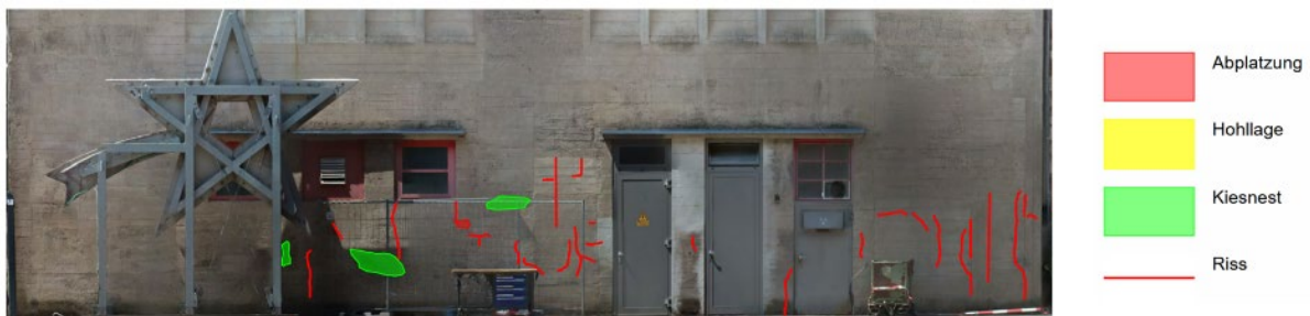
Abb. 24: Schadenskartierung Südfassade
