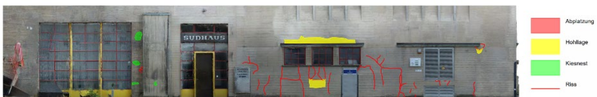
Abb. 22: Schadenskartierung Nordfassade
