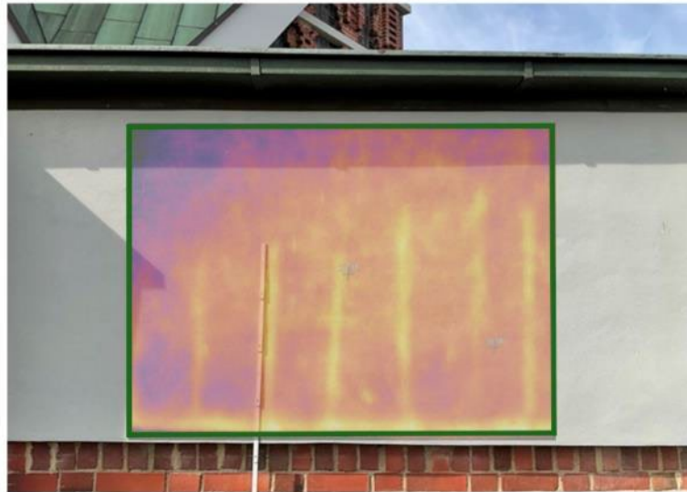
Abb. 11: Wärmebildaufnahme eines Stahlbetonelements der Ostfassade
