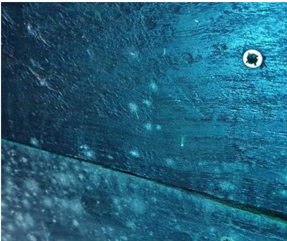
Abbildung 20 Sichtbarkeit des Schimmels bei UV-C und IR-Beleuchtung 2020© iXtronics-Hajuveda
