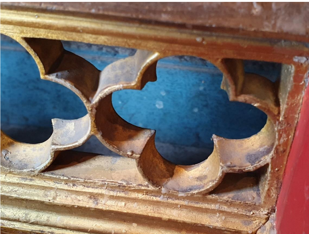
Abbildung 90 eventuell Schimmel auf blau gefärbten Träger 2021© iXtronics-Hajuveda
