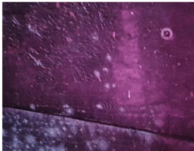
Abbildung 20 Sichtbarkeit des Schimmels bei UV-C und IR-Beleuchtung 2020© iXtronics-Hajuveda
