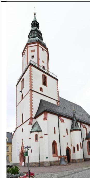
Links: Döbeln, St. Nikolai, Ansicht aus westlicher Richtung
