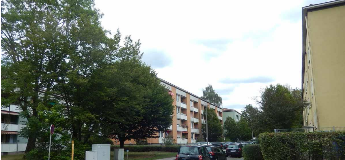
Abbildung 11 Blick von Westen in das Quartier Heinrich-Hertz-Straße
