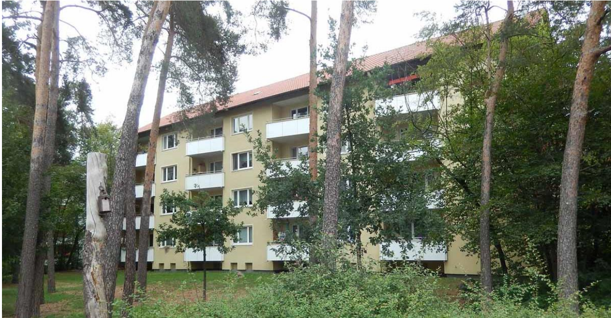
Abbildung 5 Hochwertige Freiflächen mit zahlreichen Bäumen, Paul-Gossen-Straße 85-87
