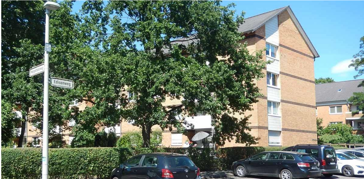
Abbildung 17 Ansicht Edisonweg 4 und 4a
