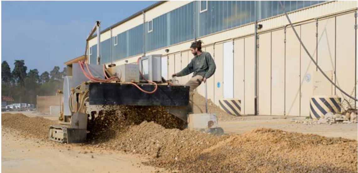
Abb. 16 Aufbereitung des lokalen Aushubmaterials zum Rohmaterial zur Herstellung von maschinell vorgefertigten Stampflehmelementen. Foto Lehm Ton Erde Baukunst GmbH
