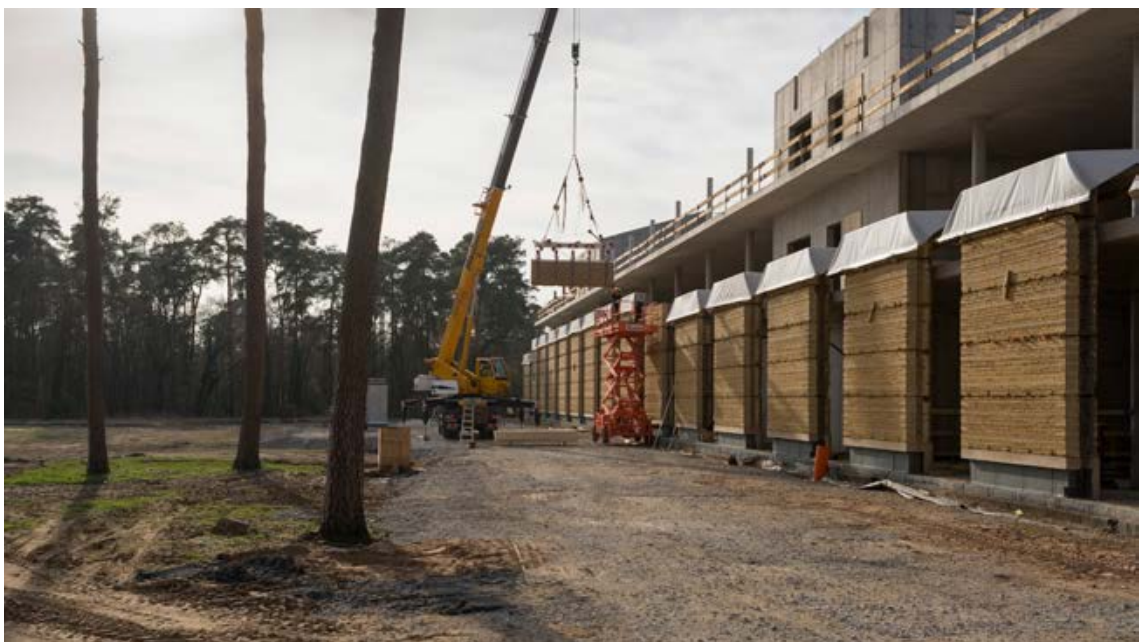
Abb. 21 Versatz der vorgefertigten Stampflehmelemente mittels Baukran. Foto Lehm Ton Erde Baukunst GmbH
