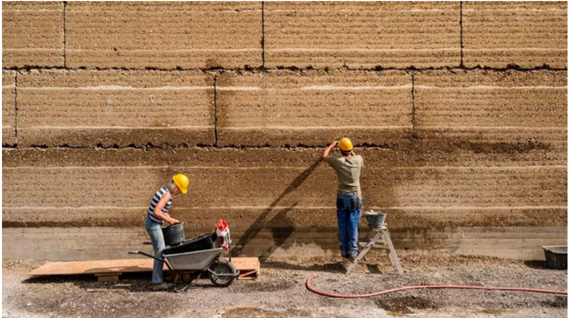
Abb. 1 Beispiel einer Stampflehmwand; hier Ver fugen einer 11 m hohen Wand aus Stampflehmelementen; Herzog de Meuron/Martin Rauch
