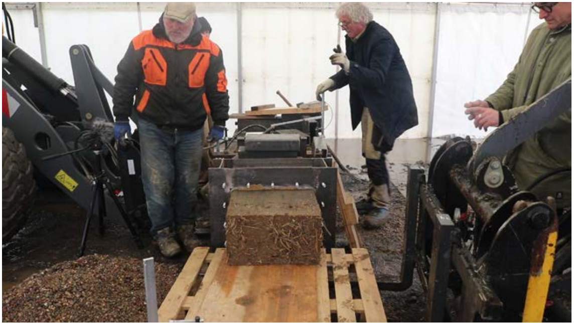
Abb. 31 Ein Wellerlehmblock wird nach dem Kompaktierungsvorgang aus der Kammer herausgedrückt. Videostill Ute Reeh
