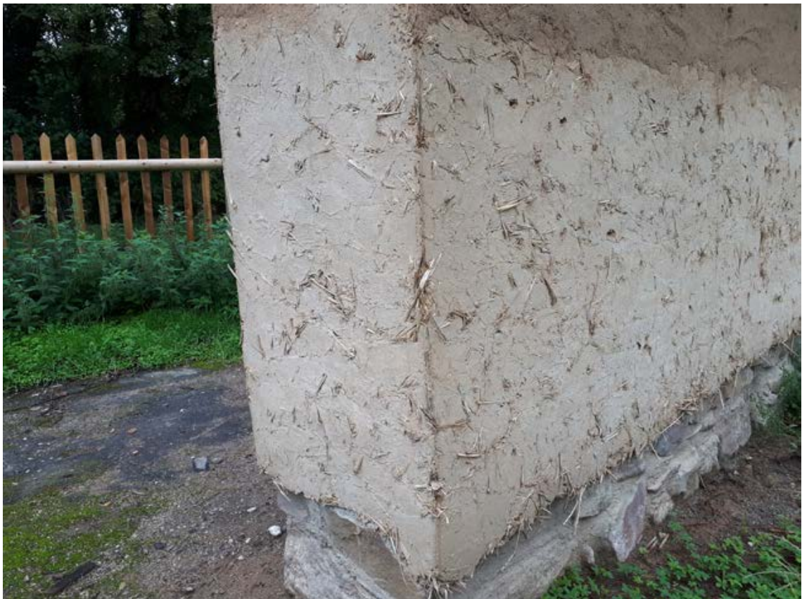
Abb. 59 Geschalte Wellerlehmoberfläche nach einem Jahr. Die Wandstärkenzugabe im Vergleich zum Sockel berücksichtigt die vorhersehbare Abwitterung. Foto Christian Hansel
