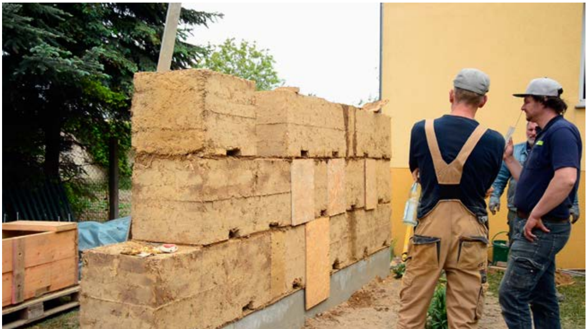
Abb. 37 Aufbau des Wellerlehmschnitts der Probewand aus vorgefertigten Blöcken. Links im Bild eine Verschalung zur manuellen Herstellung vorgefertigter Wellerlehmblöcke. Rechts im Bild die Lehmbauer Christian Hansel und Henry Krüger im Gespräch, hinten Burghardt Behrendt aus Nebelin (Videostandbild Daniel Beltrán).
