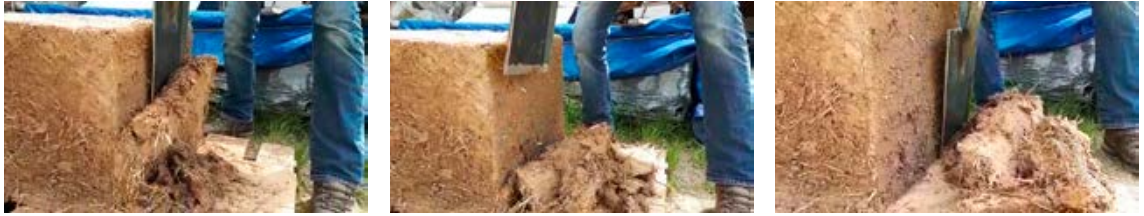
Abb. 25 Drei Videostandbilder, die das manuelle Begradigen von Wellerlehm durch 'Abstechen' mittels eines speziellen Abstechspatens zeigen (traditionelles Verfahren). Video Lehmbau Lovis UG
