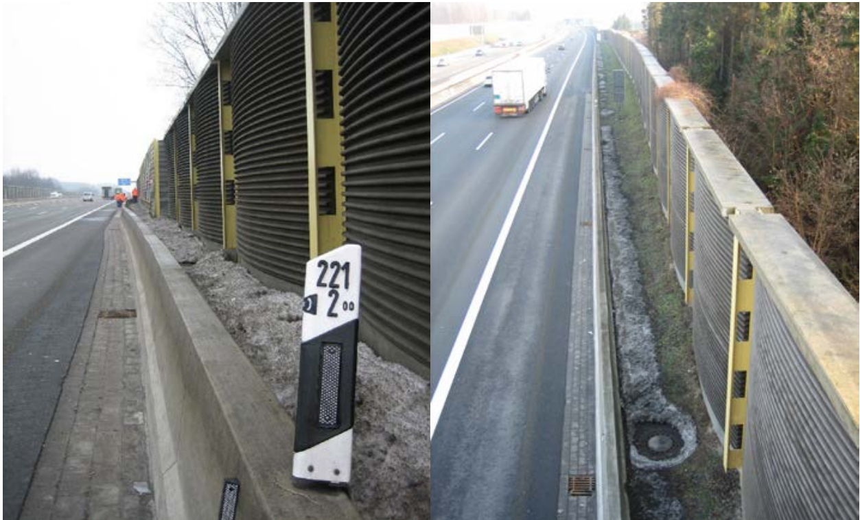
Abb. 61 Lärmschutzwand mit vorgelagerter Schutzeinrichtung (Betonschutzwand) bei beengten Platzverhältnissen an der BAB A1; im Zwischenraum Schneereste vom Winterdienst. Foto BAST
