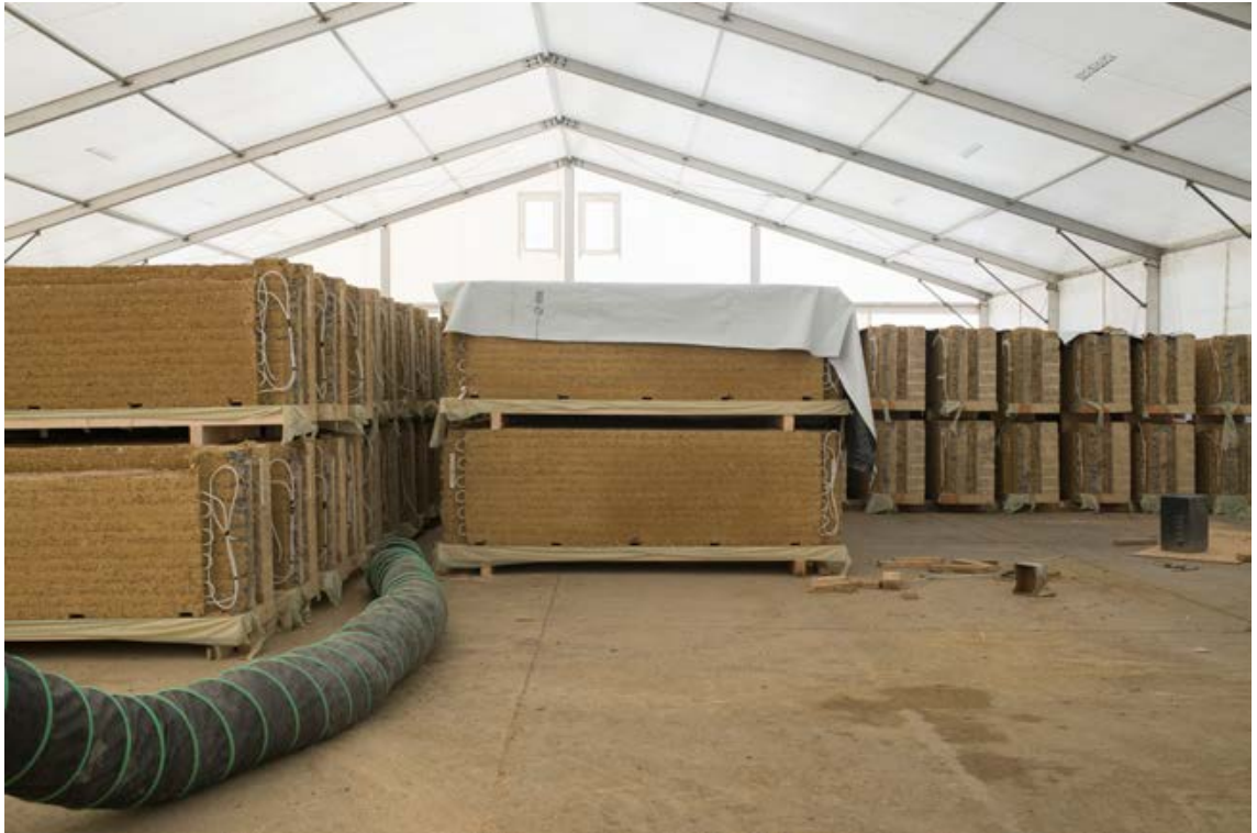
Abb. 20 Trocknungsprozess der Stampflehmelemente in einem temporär eingerichteten Zelt. Foto Lehm Ton Erde Baukunst GmbH
