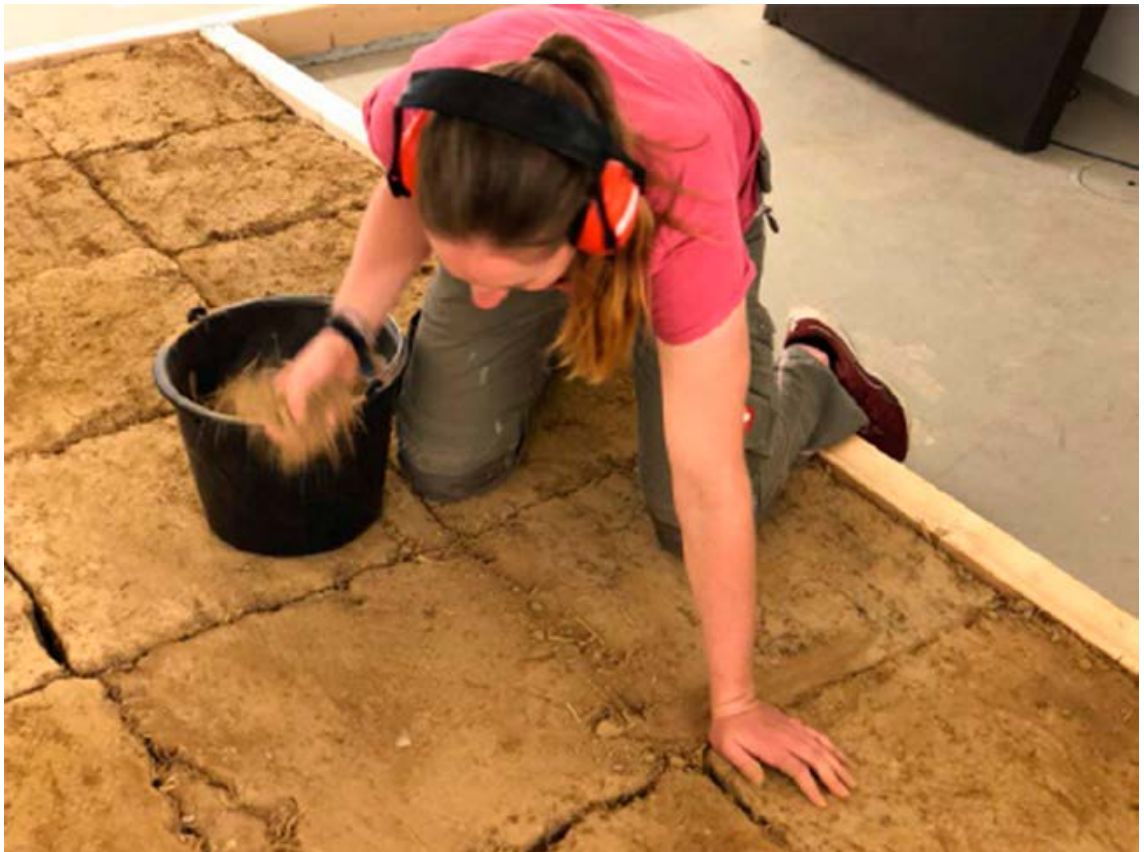
Abb. 64 Testreihe 2: Verfüllen der Oberflächenfugen auf der Testfläche aus vorheriger Testreihe 01. Foto Heiner Lippe
