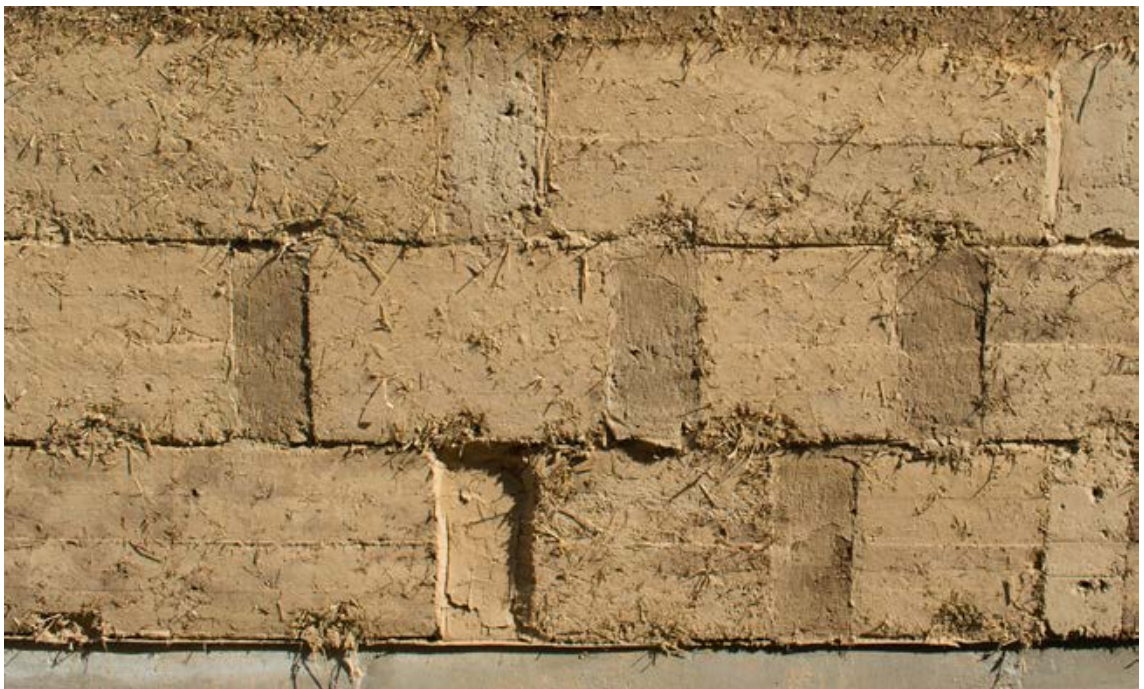
Abb. 47 Das Foto zeigt einen Ausschnitt des Wellerlehmabschnitts der Testwand in Nebelin. Die schmalen, integrierten Elemente aus unarmiertem, nur schwach kompaktiertem Naturlehm sind gut zu erkennen. Zur Zeit der Aufnahme waren diese ‚Bienenlehm‘-Elemente noch nicht durchgetrocknet und die Wand noch nicht durch Abfräsen egalisiert. Foto Ute Reeh
