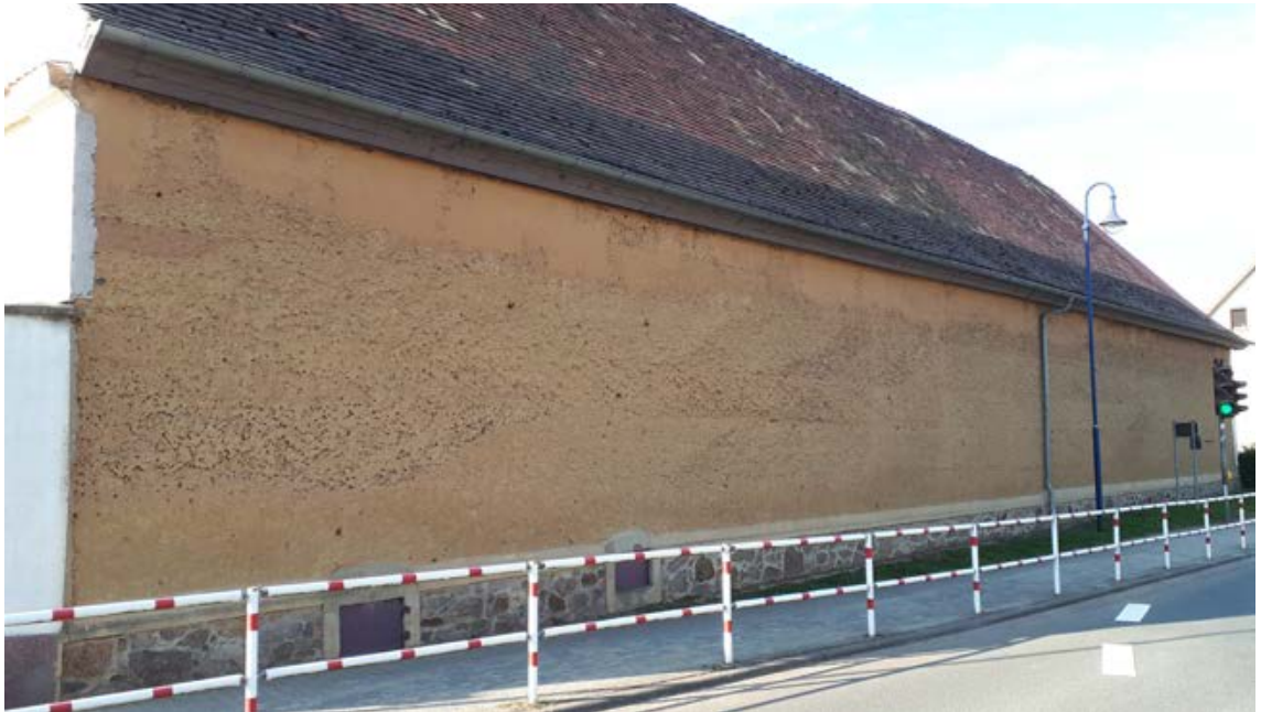
Abb. 51 Rackwitz (Sachsen), Leipziger Str.1; Alter ca. 130 Jahre, Dicke: 80 cm, Straßenabstand : 2-3 m, Höhe mit Sockel: 4,50 m, Substanzverlust: ca. 5 cm. Foto Christian Hansel
