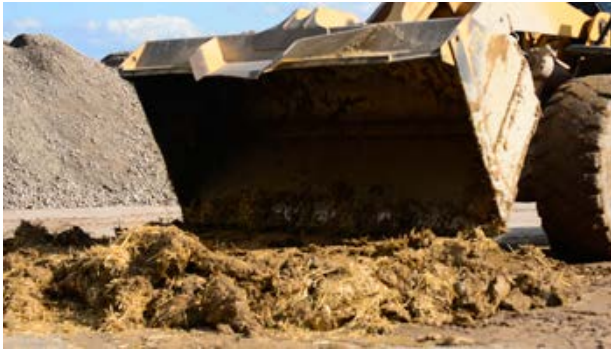
Abb. 38 Mischen von Wellerlehm-Masse mit einem Radlader im Kieswerk (Videostandbild Daniel Beltrán)
