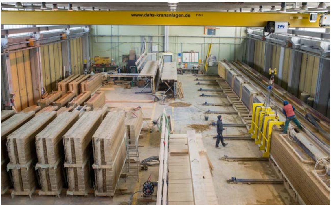
Abb. 19 „Feldfabrik“ in einer angemieteten Lagerhalle, maschinelle Vorfertigung von Stampflehmelementen; Foto Emmanuel Dorsaz / Lehm Ton Erde Baukunst GmbH
