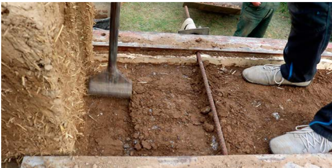
Abb. 40 Stampfen mittels eines pneumatischen Stampfers. Links im Bild ist der Anschluss zum Wellerlehmabschnitt der Testwand zu sehen (Videostandbild Daniel Beltrán).
