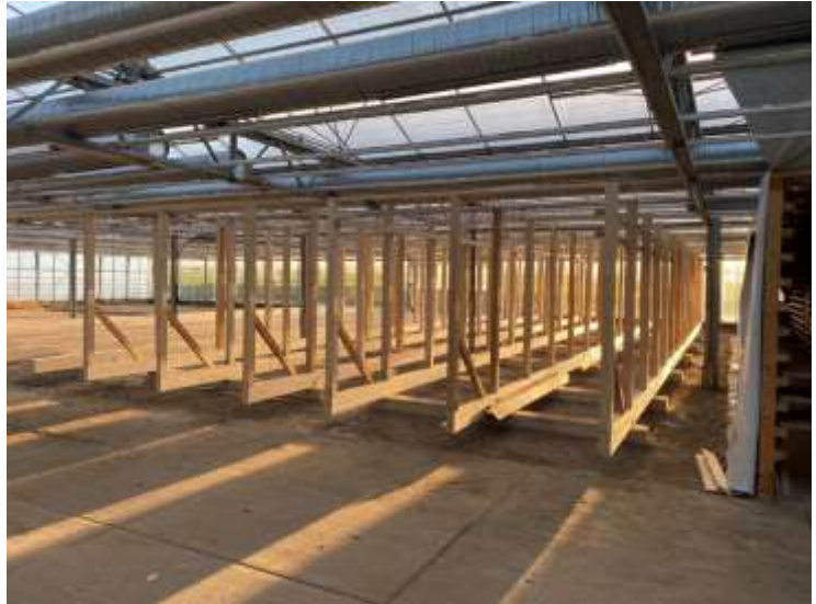
Abbildung 20: Bau der Trocknungsanlagen
