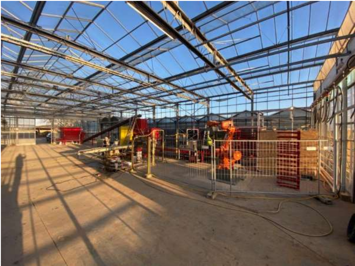
Abbildung 4: Blick in das Gewächshaus in der Umbauphase
