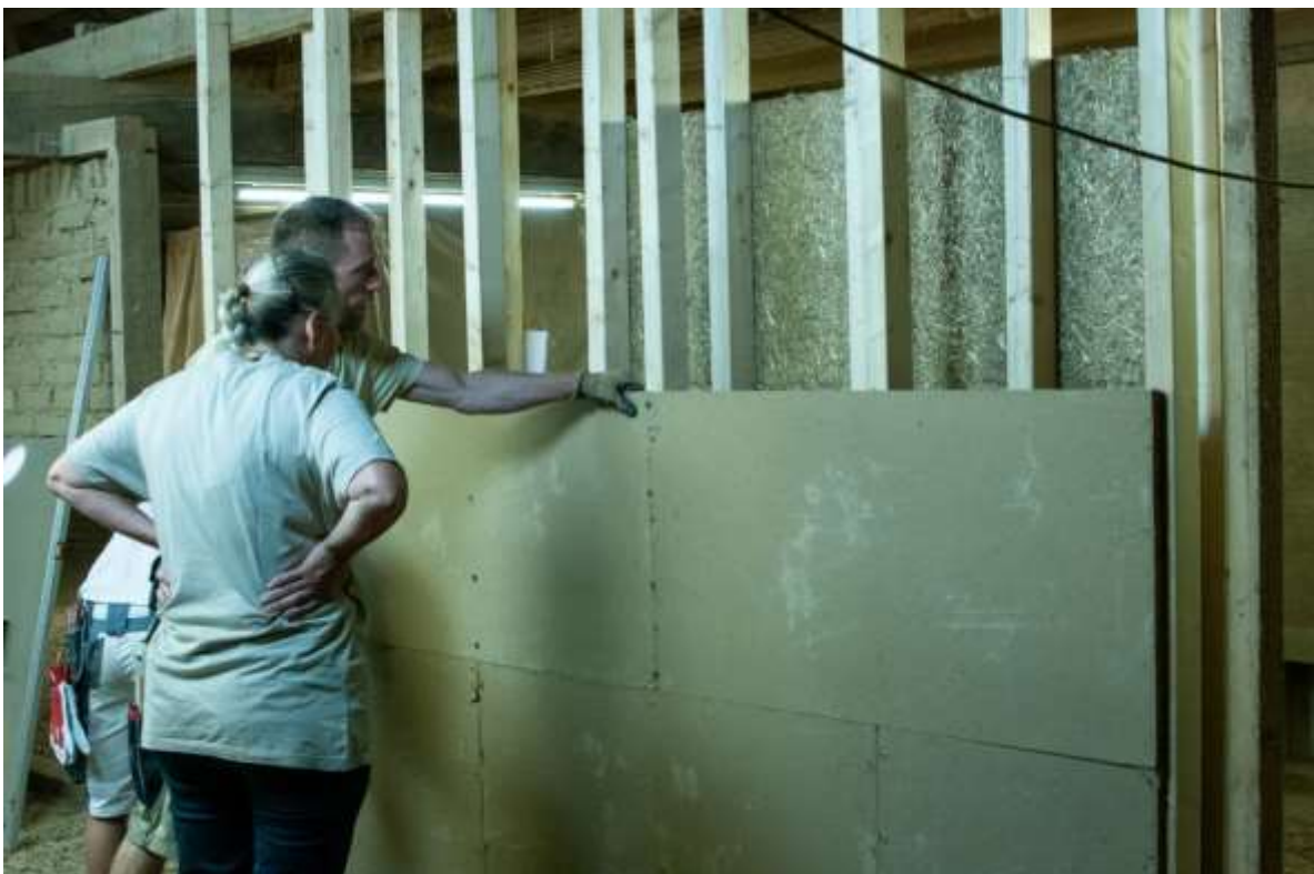
Abbildung 17: Trockenbauversuch mit Solar-Lehmplatten
