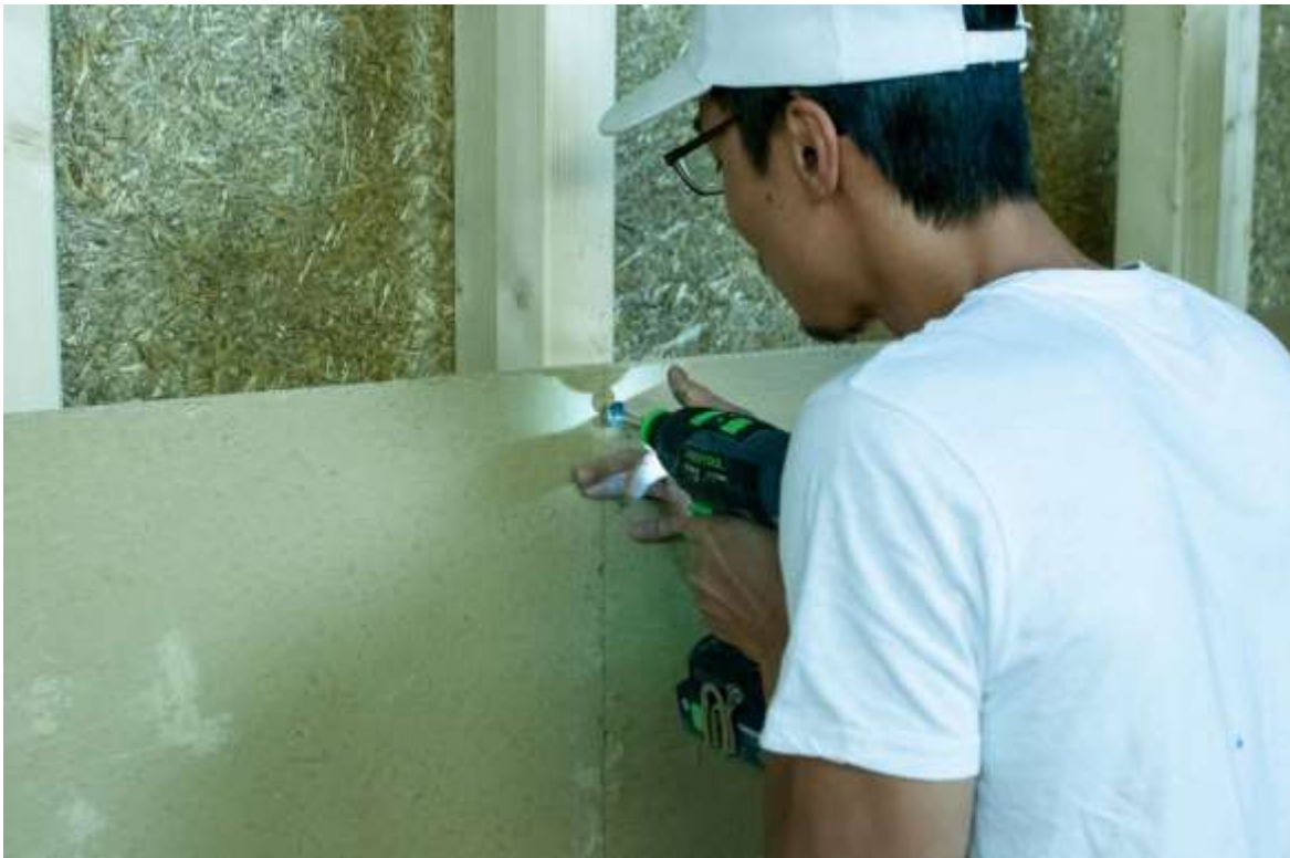
Abbildung 19: Verschraubung der Solar-Lehmplatten
