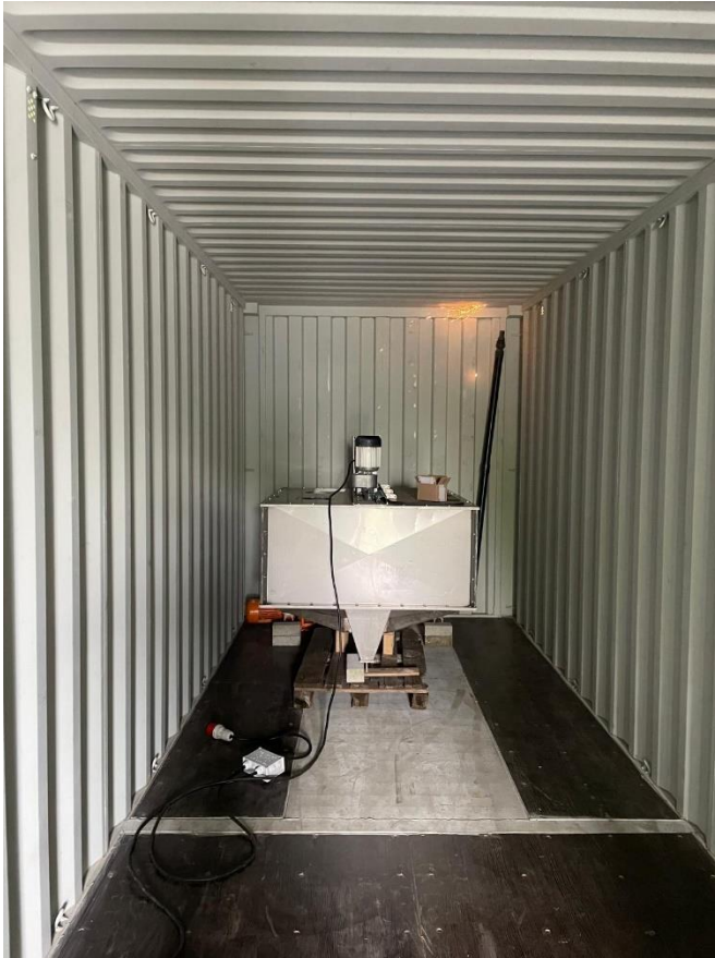
Abbildung 6: Gebrauchte Fütterungstechnik aus der Schweinemast (Edelstahl-Mischbehälter und Schneckenpumpe) in Vorverarbeitungscontainer
