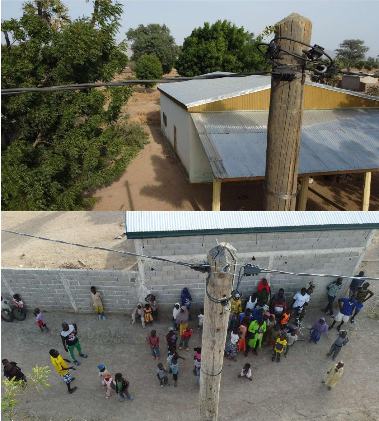
Abbildung 4: Montage der Aluminiumkabel an den Masten
