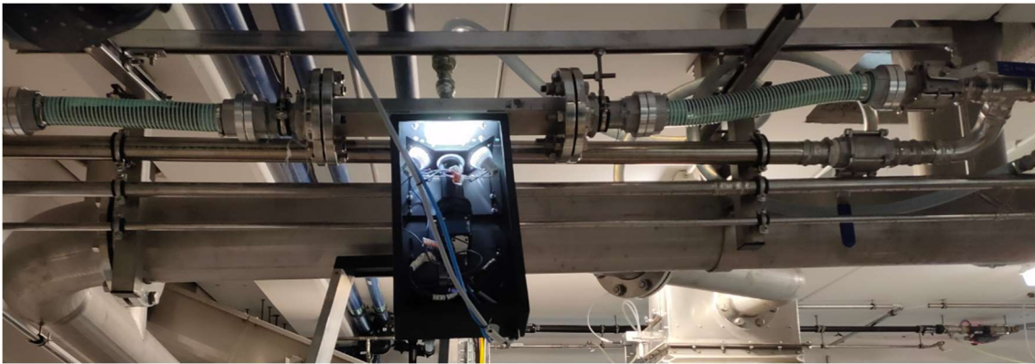
Abbildung 10 Inbetriebnahme Sensor mit Küvette
