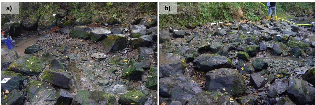
Abb. 3.5 Trockengelegte Sohlgleite (Aufnahmen: Eikenberg)
