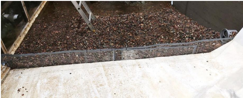
Abb. 3.29 Einbau einer Barriere für die Groppen
