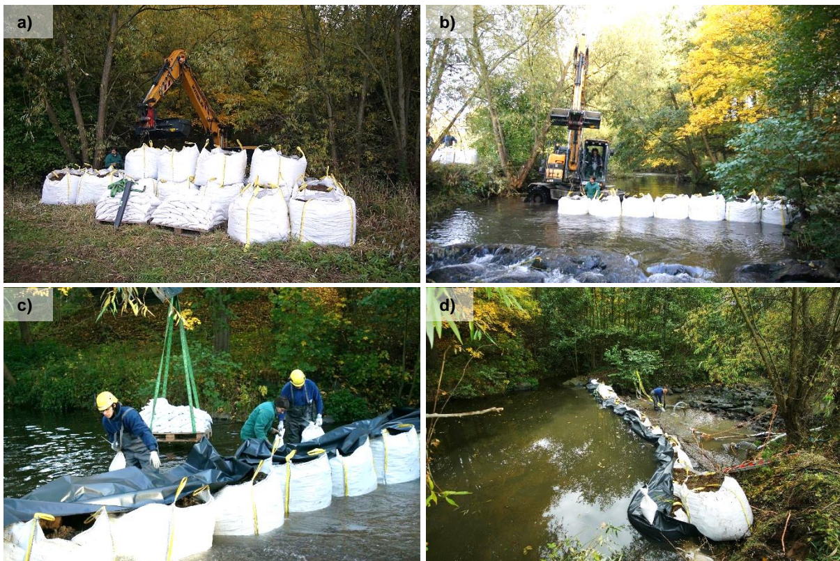
Abb. 3.3 a) bereitgestellte Bigbags und Sandsäcke; b) Einheben der Bigbags in die Ilme; c) Verlegen der Kunststofffolie und der Sandsäcke; d) Aufbau der Sperre ist abgeschlossen. (Aufnahmen: Eikenberg)
