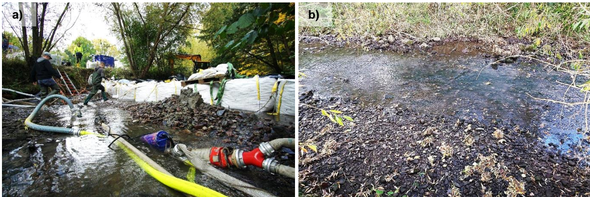
Abb. 3.4 Pumpentechnik im Einsatz und Ilme unterstrom der Gleite mit Restwasser. a) Pumpentechnik zwischen der Sperre und der Gleite; b) gepumptes Restwasser in der Ilme unterstrom der Gleite. (Aufnahmen: Eikenberg)
