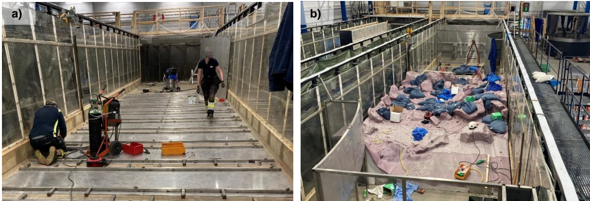
Abb. 3.16 a) Einbau der Unterkonstruktion; b) Einbau der einzelnen Modellblöcke. (Aufnahmen: Vattenfall)
