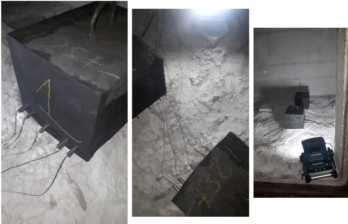
Abbildung 13: Stahlblöcke in der Brennkammer
