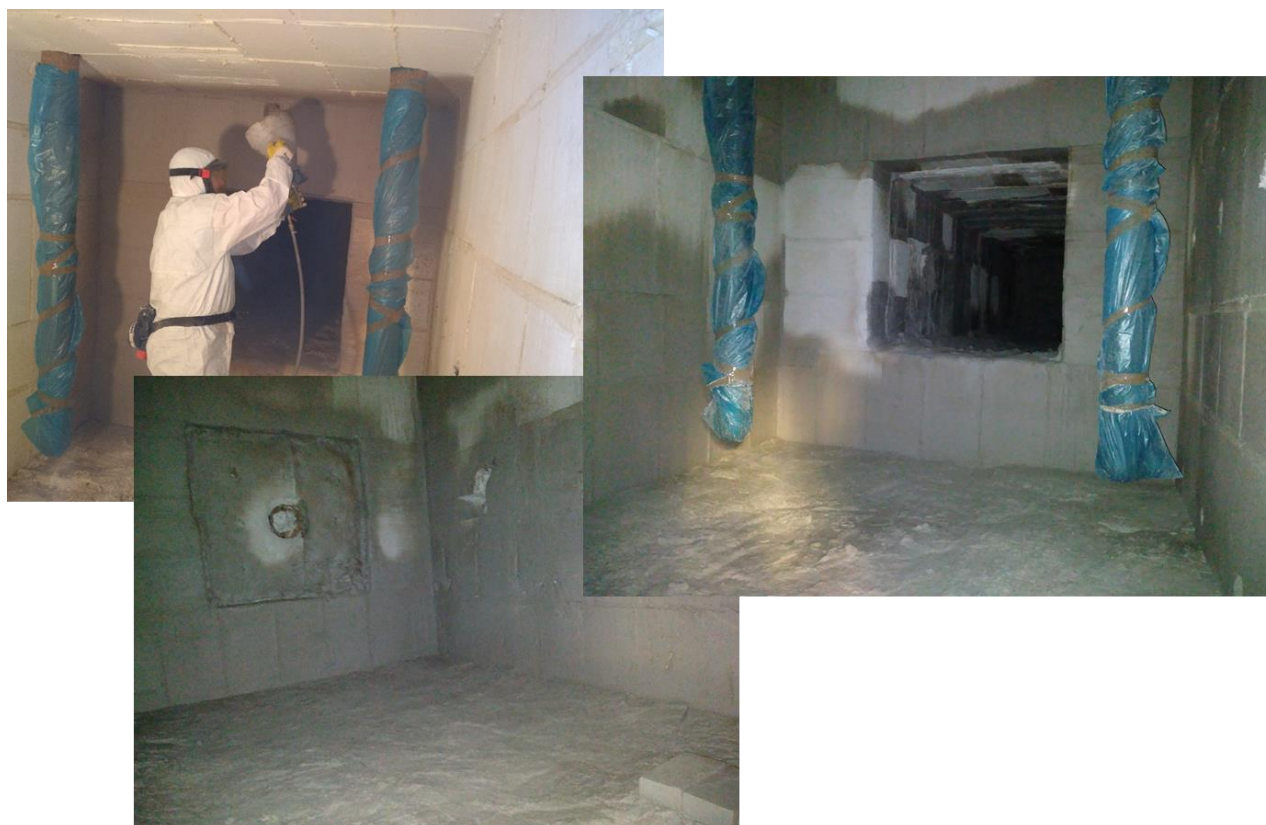
Abbildung 19: Beschichtung der Brennkammer mit dem Coating
