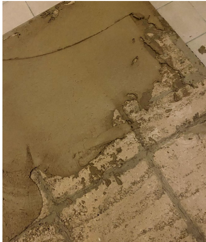
Abbildung 45: Auftragen des Lehmoberputzes
