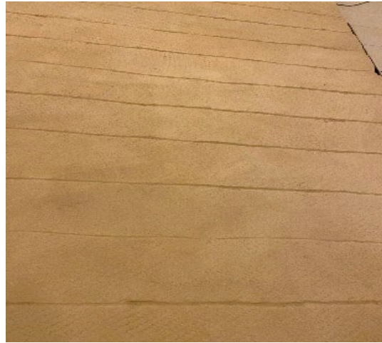
Abbildung 56: Lehmverputzte Oberfläche, bearbeitet mit einer Nadelrolle und Rillen
