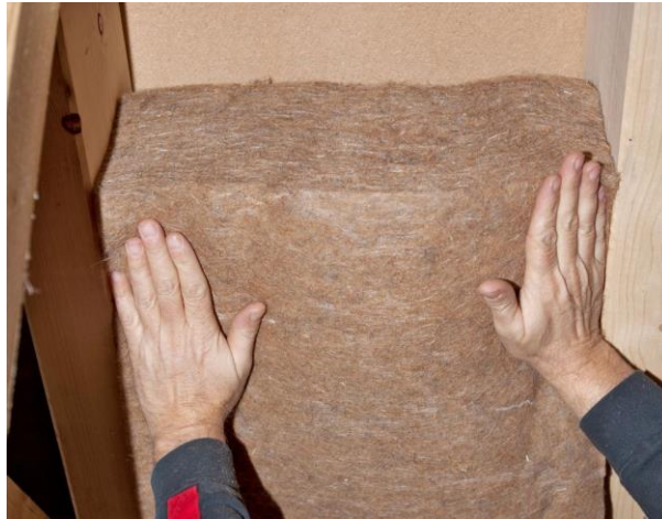
Abbildung A1.41: Jutedämmung Foto: Thermo Natur [Thermo Natur]
