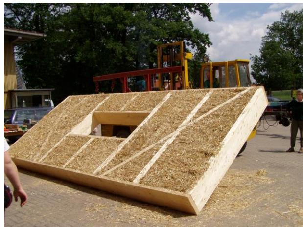
Abbildung 7: Nachbau einer gedämmten Wand aus der Bronzezeit [ https://lh.hessen.de/umwelt/biorohstoffnutzung/stoffliche-nutzung/lehm-ein-nachhaltiger-baustoff/ ]
