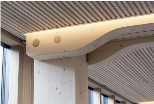
Abbildung 1: Moderne Zangenkonstruktion mit Hartholzdübel [Sindre Ellingsen]
