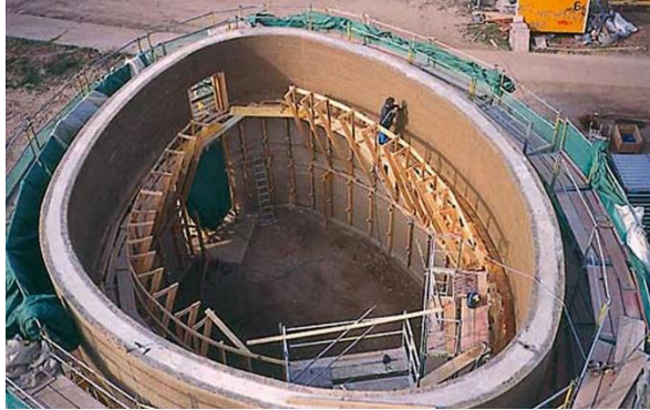
Abbildung A1.29: Baustelle Kapelle der Versöhnung [Martin Rauch]
