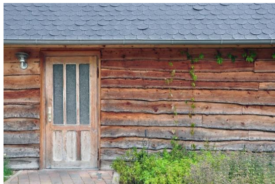
Abbildung A1.43: Holzschalung
