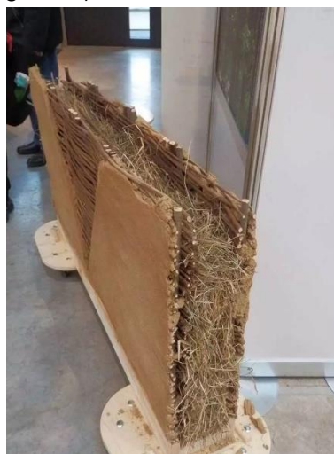
Abbildung A1.35: Nachbau einer gedämmten Wand aus der Bronzezeit
