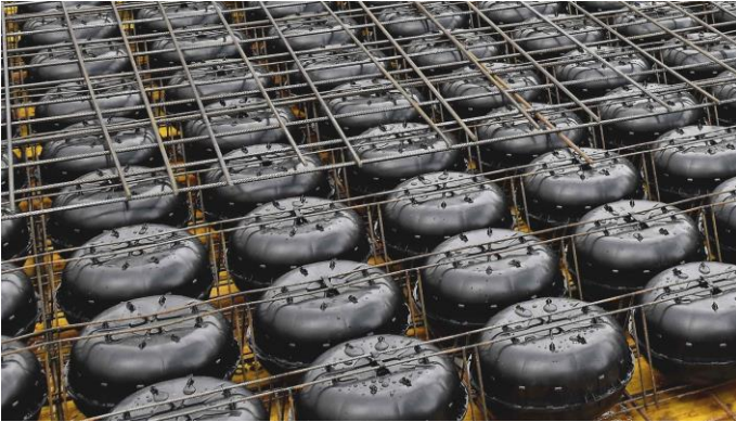
Abbildung 3: Hohlkörper in Betondecke [Heinze Cobiax Deutschland GmbH.]
