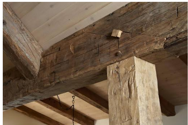
Abbildung 1: Moderne Zangenkonstruktion mit Hartholzdübel [Sindre Ellingsen]
