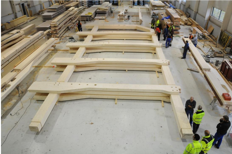
Abbildung A1.14: Vorfertigung des Holztragwerks, Finanzparken in Stavanger [Sindre Ellingsen]
