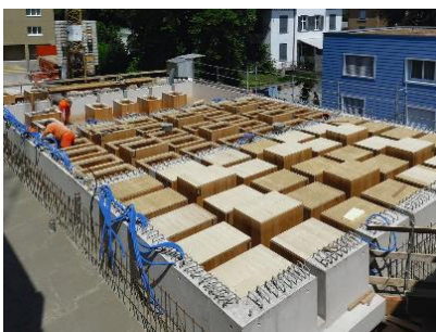
Abbildung A3.33: Kassettendecke aus Beton als vorgefertigte Schalung (links) und fertiges Bauteil (rechts) in einem Altenheim in Arbon, Singer Baenzinger Architekten, 2019 (Morris Breunig, 2020)
