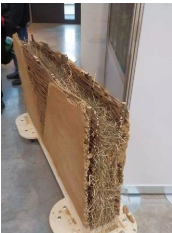
Abbildung 7: Nachbau einer gedämmten Wand aus der Bronzezeit [ https://lh.hessen.de/umwelt/biorohstoffnutzung/stoffliche-nutzung/lehm-ein-nachhaltiger-baustoff/ ]
