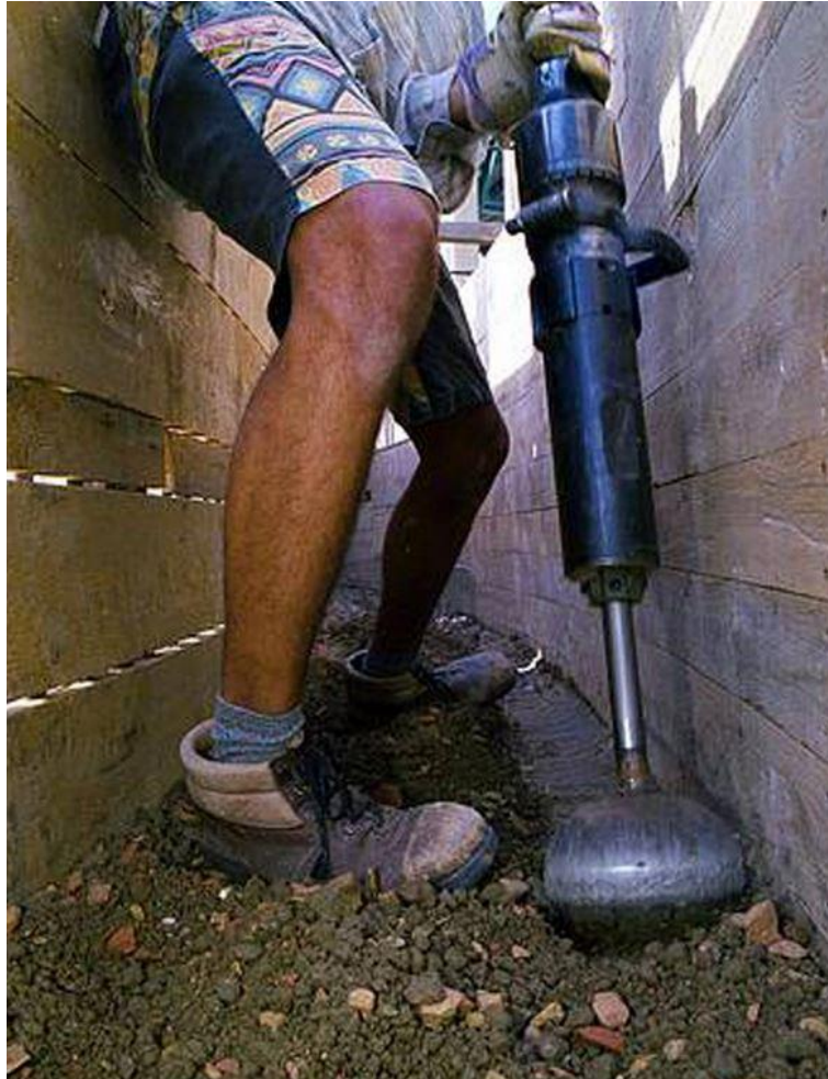
Abbildung A1.27: Manuelle Herstellung Stampflehmwand. [Martin Rauch]
