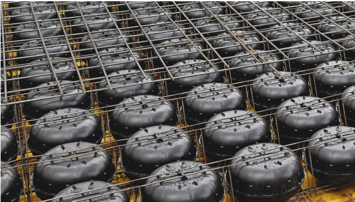
Abbildung A1.26: Hohlkörper in Betondecke [Heinze Cobiax Deutschland GmbH]
