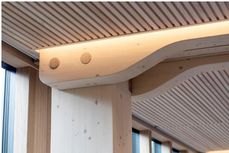
Abbildung A1.15: Hartholzdübel-Verbindung, Finanzparken in Stavanger [Sindre Ellingsen]
