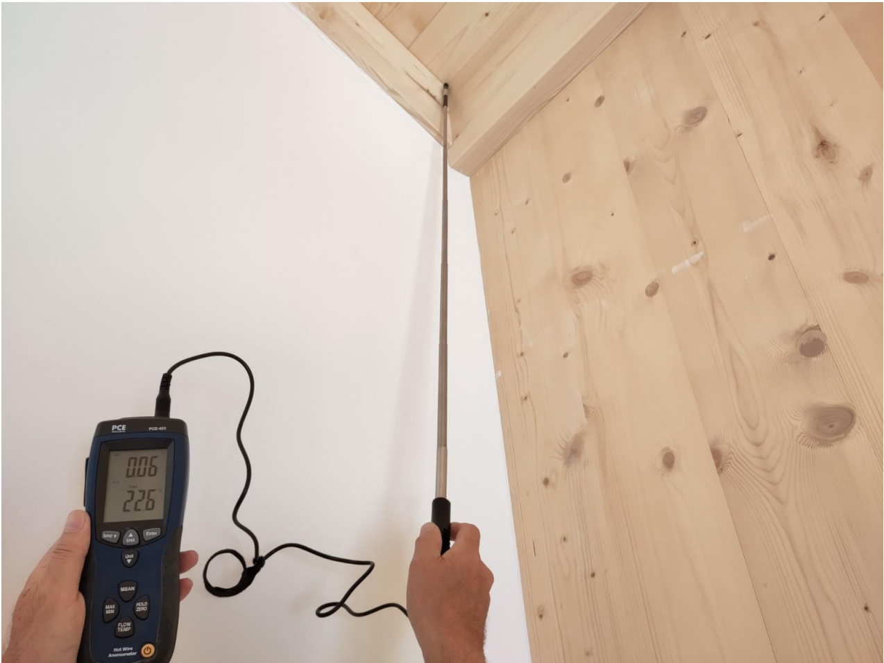
Abbildung 10: Luftundichtigkeitsprüfung an Bauteilen
