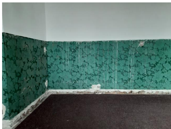
Abb. 18 Unter einer Holzpanelabdeckung erhaltene Tapete mit Schweinfurter Grün
