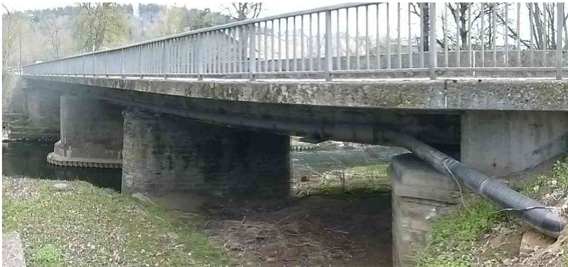
Abbildung 2: Beispiele von freiverlegten Gasleitungen an Brücken über Bahntrassen (oben) sowie Gewässern (unten)
