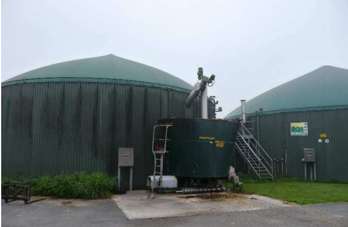
Abbildung 4: Beispiel einer Biogasanlage mit Fermenter, Nachgärer und Tragluftdach. Entnommen aus [30].
