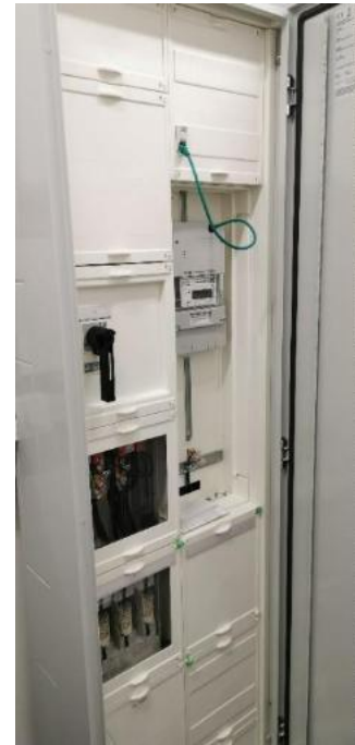
Abbildung 9 Unterverteilung Batteriespeicher
