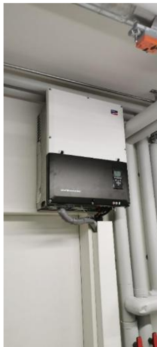
Abbildung 25 Batteriewechselrichter
