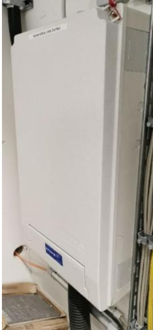
Abbildung 5 Hausanschlusskasten
