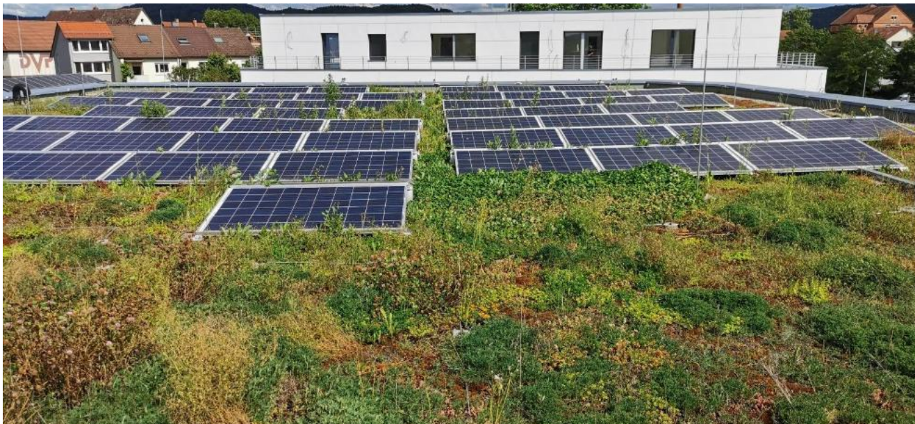
Abbildung 3 PV Anlage I
