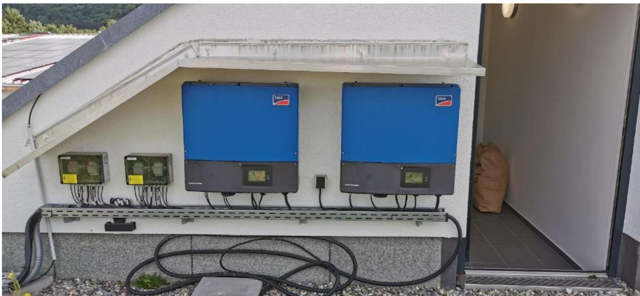
Abbildung 4 Wechselrichter SMA
