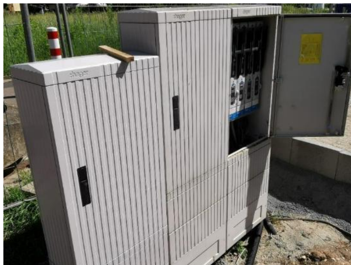
Abbildung 11 Außenverteiler
