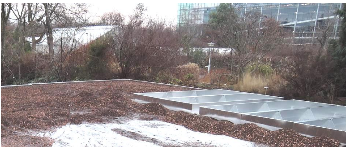
Abbildung 2.1-2: Einbausituation mit Aluminiumwannen integriert in die Grundbegrünung.
