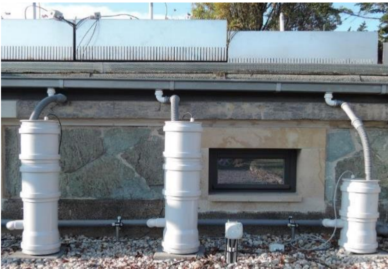
Abbildung 2.3-3: Sammelbehälter mit Messung von geschlitztem Auslass.
