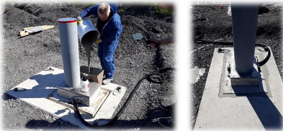
Abbildung 29 Verguss Kunststoffmörtel CTS
