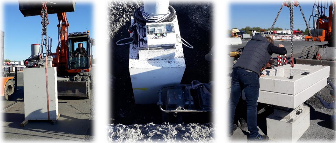
Abbildung 28 Einbau Poller CTS
