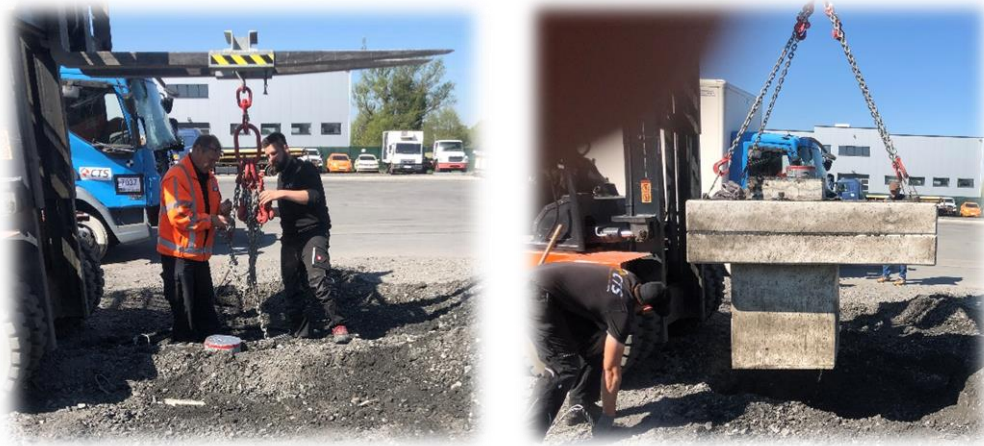
Abbildung 36 Rückbau Sicherheitspoller
