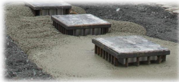
Abbildung 5: Beispiel Frischbetonverarbeitung Sicherheitspoller
