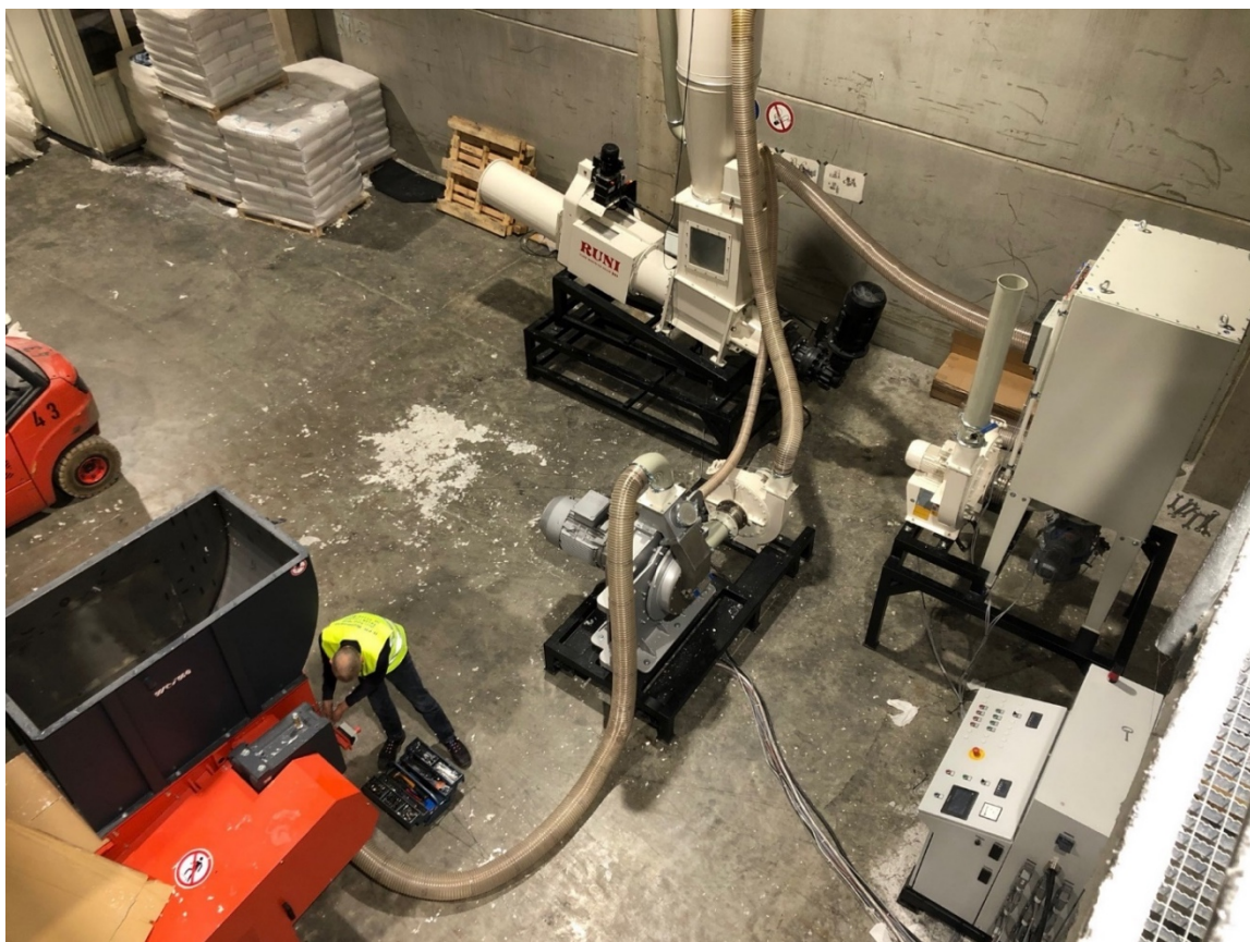
Abbildung 8: Einsatz der mobilen Testanlage DPS 40 GT II bei einem Tissuehersteller
