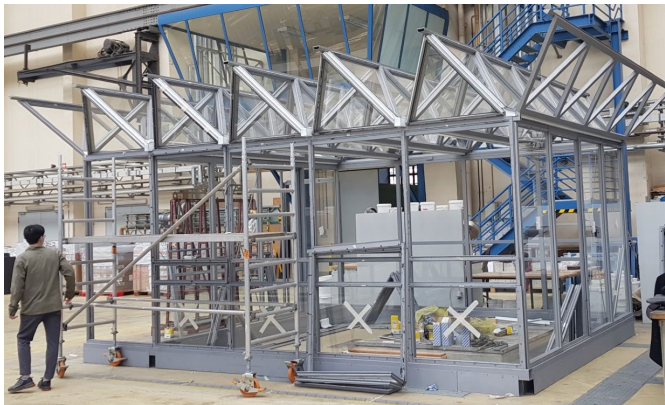
Abb.52 Aufbau des Mock-Ups, Versuchshalle TU Berlin
