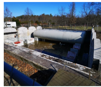
Abb.73 Foto des Öltanklagers nach Entnahme von 3 Öltanks
