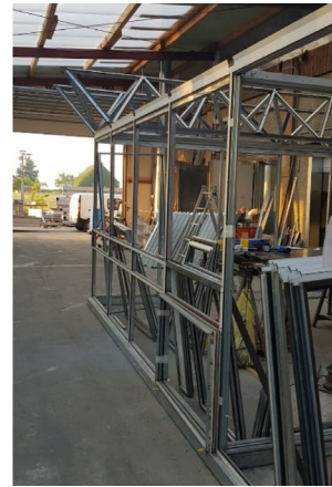
Abb.51 Bau des Mock-Ups, Werkstatt Modesta
