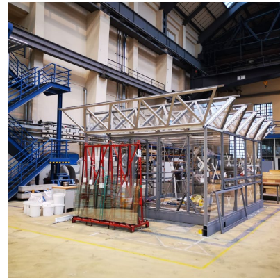
Abb.53 Einbau der Verglasung im Mock-Up, TU Berlin
