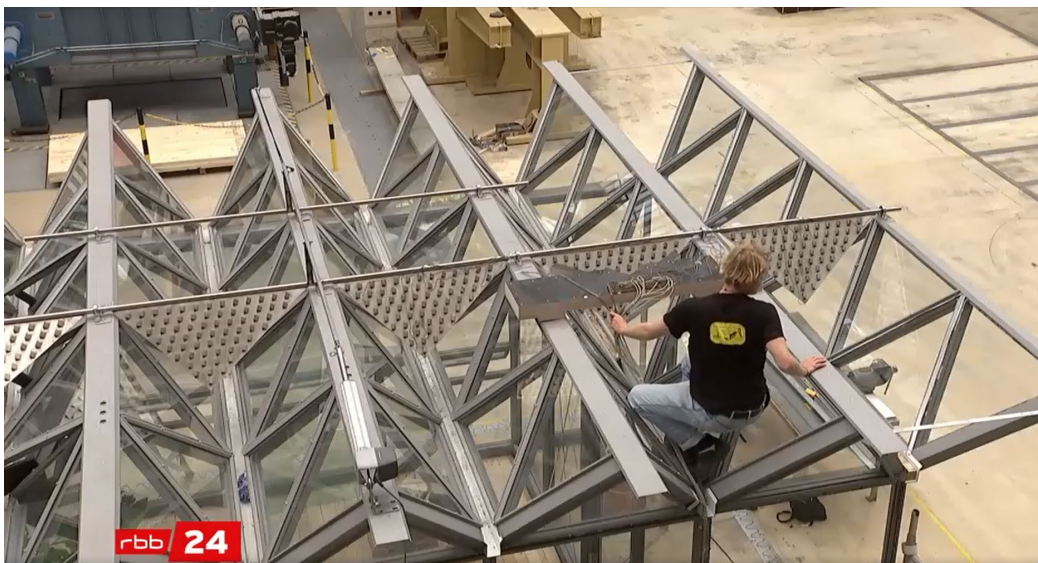
Abb Videosequenz des Mock-Up-Baus der wandelbaren Dachverschattung (Quelle: rbb/2023)
