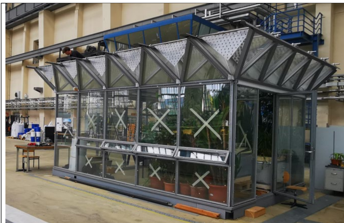
Fertig verglaster Prototyp mit Wänden und Dach; sieben Hoch- und sechs Tiefpunkte im Sheddach bieten Raum zum Parken der Verschattungsbleche.
