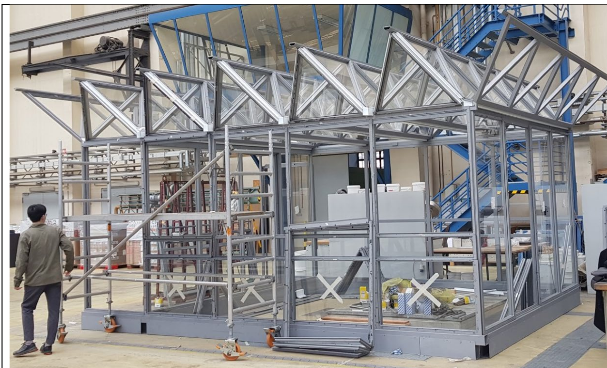
Bioklimatischer Prototyp im Rohbau ohne Wandverglasung.
