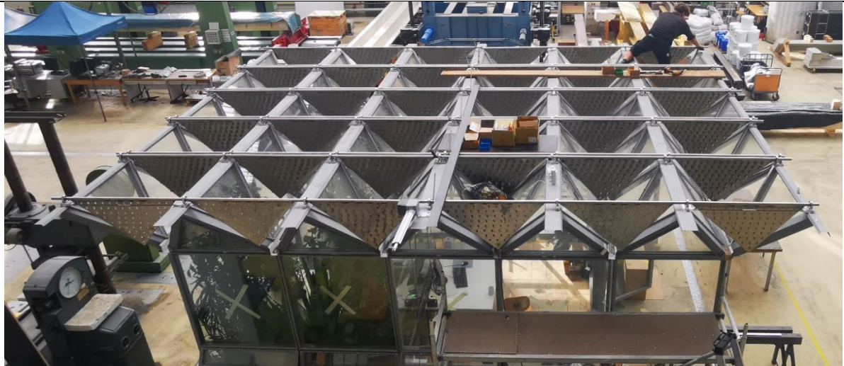
Dachverschattung: Voller Sonneneinfall, Schattenbleche in den Shed-Tälern „geparkt“.
