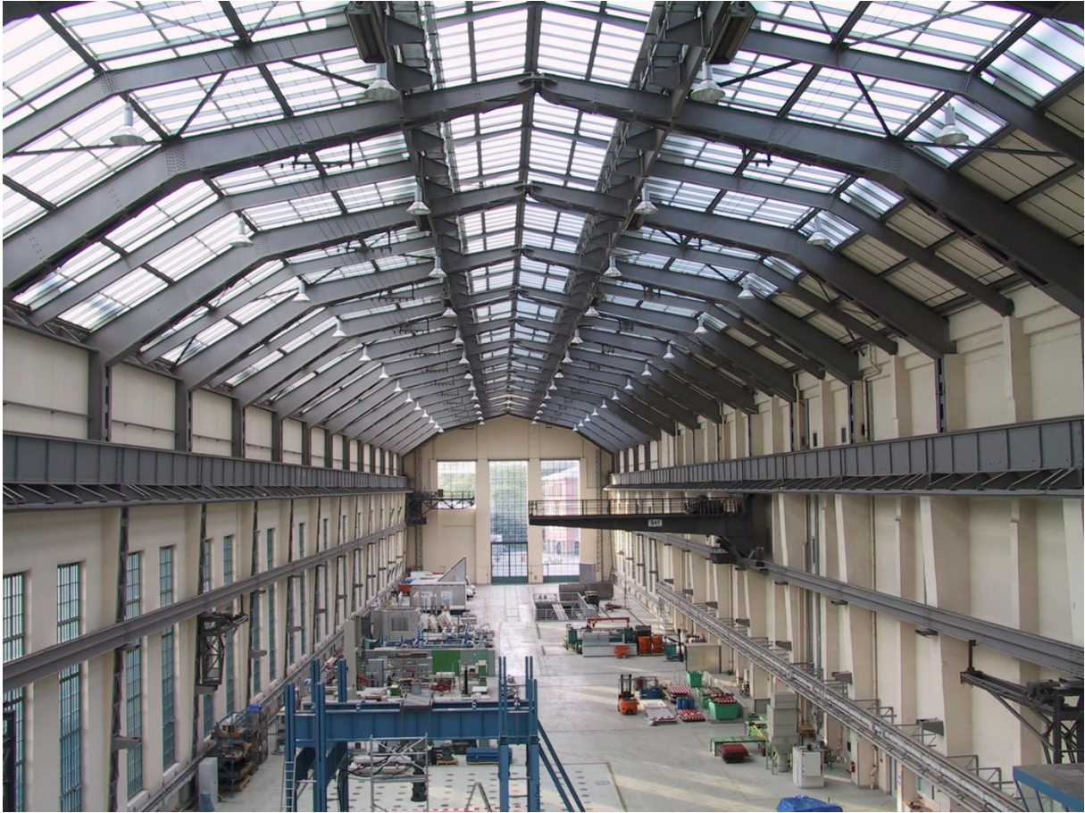
3 Peter-Behrens Halle von innen (Achim Bleicher 2005).
