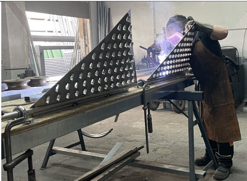
Dachverschattung: Verschweißen der Schattenbleche mit der Welle; vorab montierte Lagerböcke.
