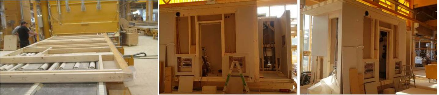
Abbildung 52: Vorinstallation Sanitär Wasser und Abwasser WC Spülkasten, Montage Heizung/Lüftung/ Heizkreisverteiler (Quelle: Baufritz)
