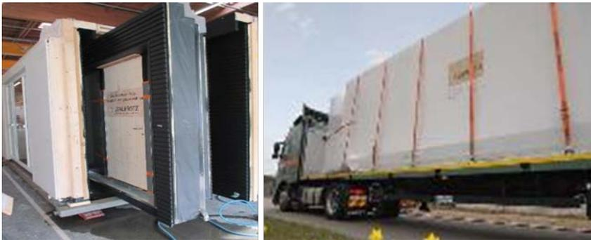
Die Außenwände des Energiewendemoduls werden als Flächenelemente geplant. Hingegen ist das Versorgungsherz ein Raummodul. Es enthält Anlagentechnik, Badezimmer, Heizungszentrale und Wärmeverteilung in Form von Wandheizungen. Das Modul hat eine hohe Dichte an Technik und Funktionen, sodass eine Fertigung als Modul sinnvoll ist.
