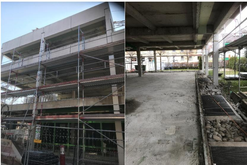
Mitte 2021 wurde der Rohbau fertiggestellt, sodass die Installation der Heizung und Lüftung erfolgen kann. Parallel wurden die Statik, die Dichtigkeit und die Dämmung der Sparkasse ertüchtigt oder angepasst. Ab Sommer 2021 beginnen die Arbeiten an der Fassade der Sparkasse: Fenster und Fassadenelemente werden produziert und die Holzfassade installiert.
