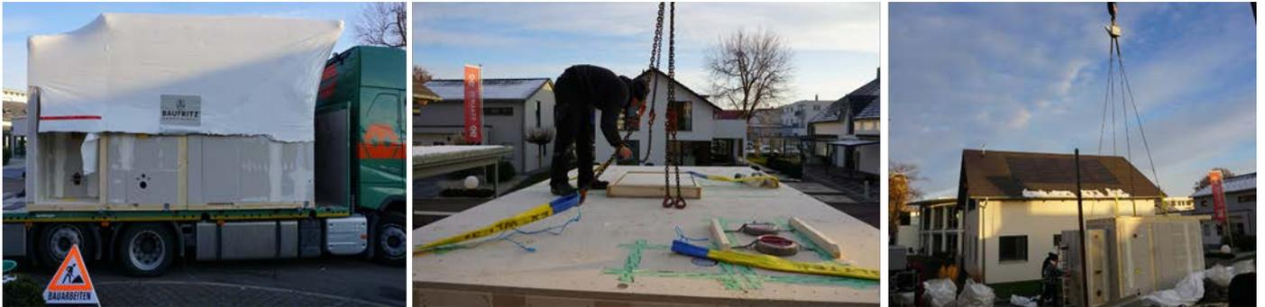
Das Versorgungshertz wird in das Gebäude auf ein Mörtelbett gesenkt. Anschließend werden die Leitungen angeschlossen (Abbildung 54).
