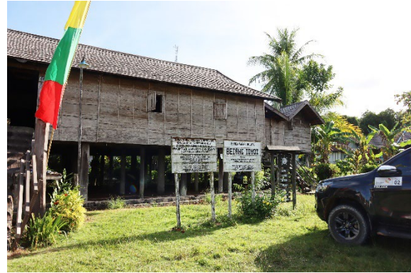
Abbildung 5: traditionelles aufgeständertes Langhaus in Zentralkalimantan (Quelle: Löffler_Schmeling)
