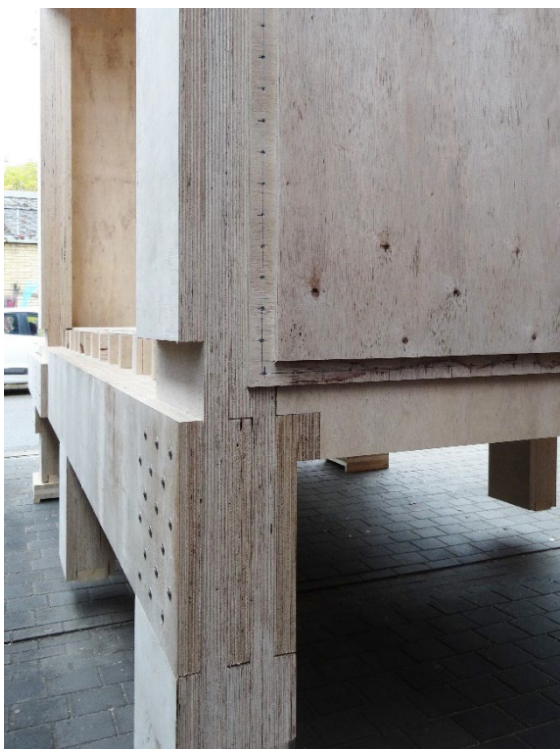
Abbildung 25: Detail des Musteraufbaus - Additives Fügen (Quelle: Löffler_Schmeling)
