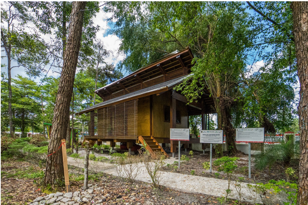
Abbildung 58: das fertiggestellte Pilotprojekt in Palangka Raya (Quelle: Fairventures)
