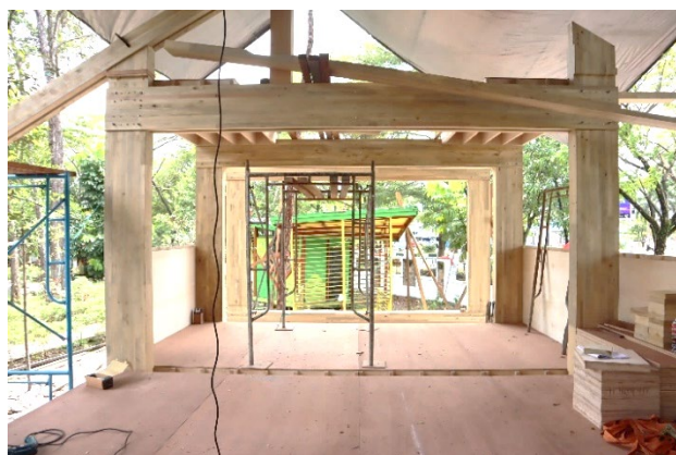
Abbildung 38: tragende Grundstruktur (Quelle: Löffler_Schmeling)
