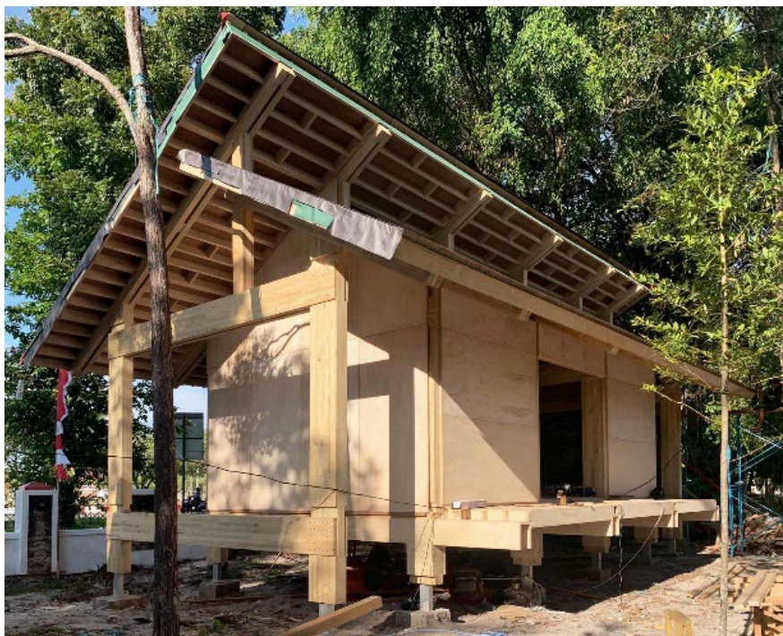
Abbildung 40: der Rohbau Anfang August 2020 (Quelle: Fairventures)
