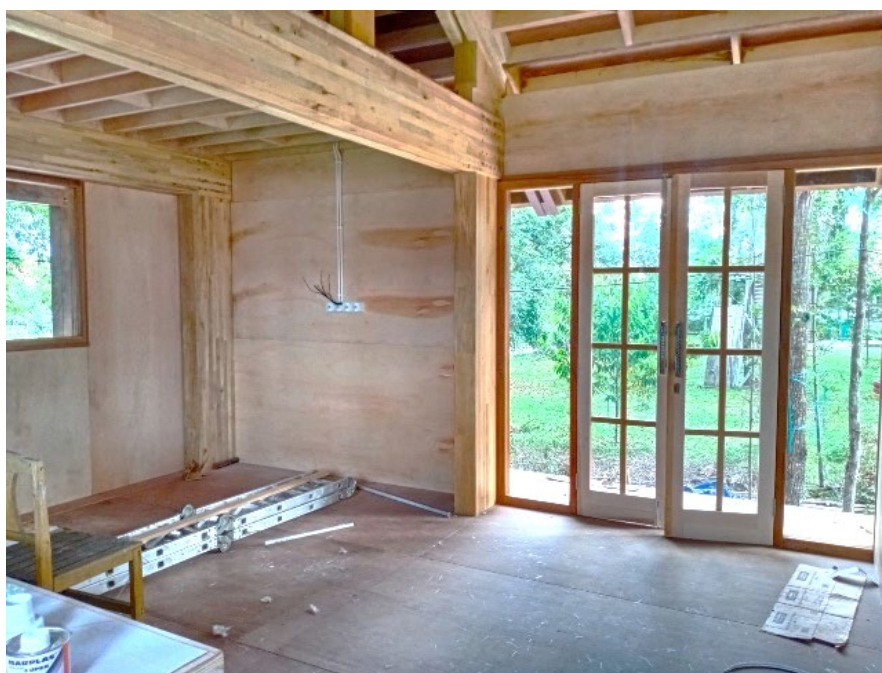
Abbildung 41: Innenraum während der Bauphase (Quelle: Fairventures)
