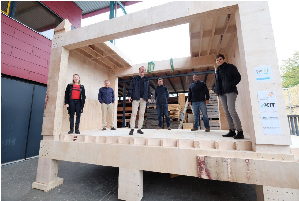
Abbildung 27: Testaufbau Modul, aufgebaut in der Versuchsanstalt (Quelle: Fairventures)
