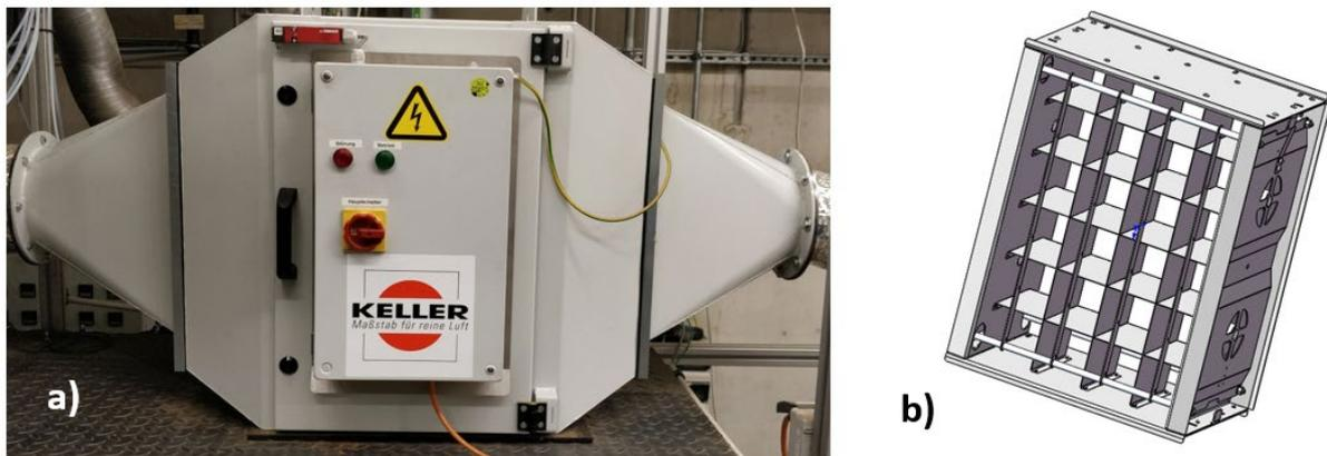
Bild 3-17 a) Elektrostatischer Abscheider b) Abscheidepaket (Innenansicht)
