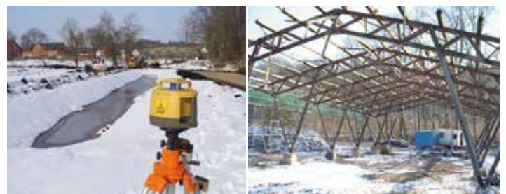
Abb. 4: Neubau- und Sanierungsarbeiten
