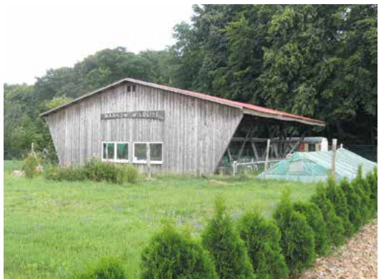
Abb. 6: Ansicht der Kreislaufanlage von außen
