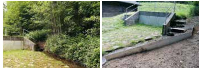
Abb. 12: Im Heubach eingebaute Doppelsperre mit Leitfunktion (links vorher/rechts nachher)
