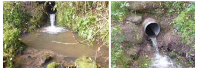
Abb. 11: Maßnahme am Heubach: Anbringen einer Stahlmanschette mit Überkrragung im Rohr zur Optimierung der Schutzwirkung (vorher/nachher)
