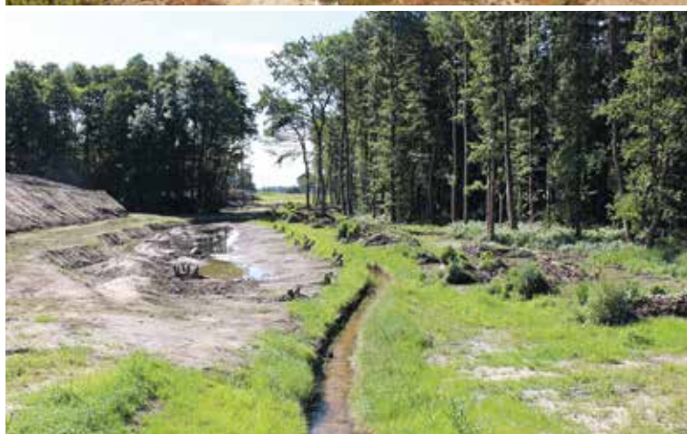
Abb. 7: Herstellung einer Sekundäraue an der Großen Mühlenhase im Landkreis Osnabrück (oben) und im Schierenbach Landkreis Vechta (unten)
