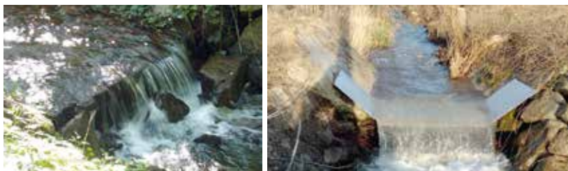
Abb. 6: Verstärkung eines bestehenden Querbauwerkes im Wollbach mit Stahlblech
