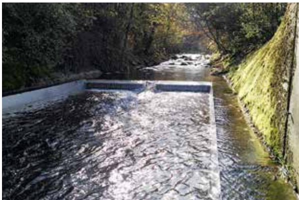
Abb. 1: Krebssperrung in der Ansicht flussaufwärts. Links und rechts sind Bermen für die Wanderung von terrestrischen Arten zu sehen in der Bildmitte der Riegel mit den auskragenden Blechen.
