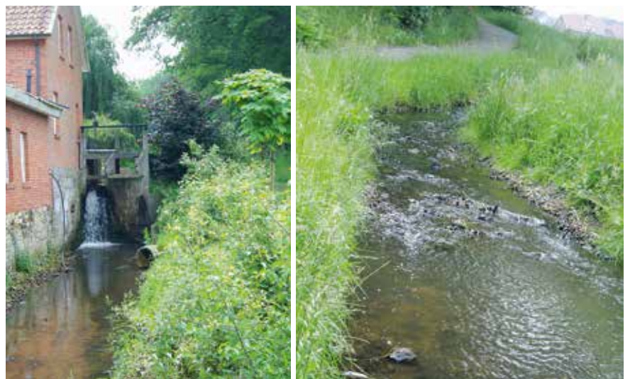
Abb. 6: Mühlenabsturz im Reitbach und Umgehungsgerinne im selben Gewässer (rechts), beides Landkreis Osnabrück
