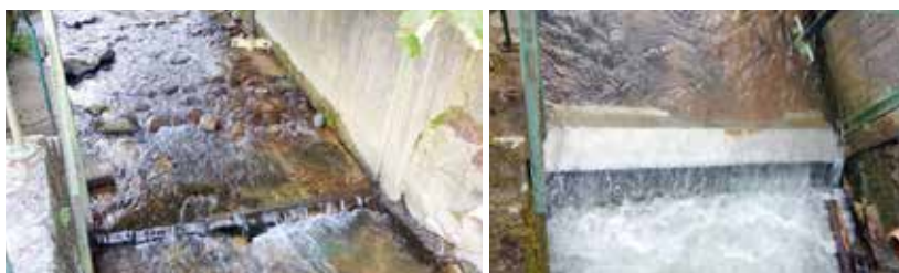
Abb. 7: Nutzung eines Feuerwehrs chützes im Lippisbach zum Einbau der Krebs sperre
