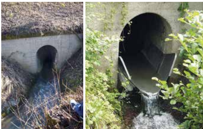
Abb. 9: Verkleidung des Rohrdurchlasses im Finsterbach mit halbschalenförmigen Edelstahlblech vorher (links) und nachher (rechts)
