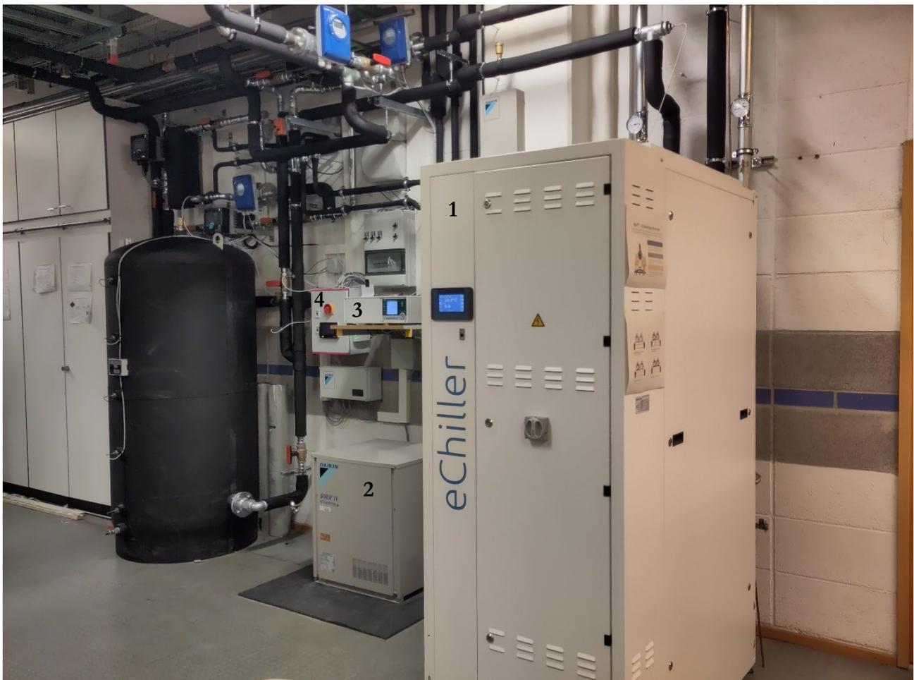
Abbildung 13: Hybridkältesystem mit den Hauptkomponenten eChiller (1), Verdichtereinheit der Split-KM (2), Datenlogger des wissenschaftlichen Messkreises (3) und Regelungseinheit (4)
