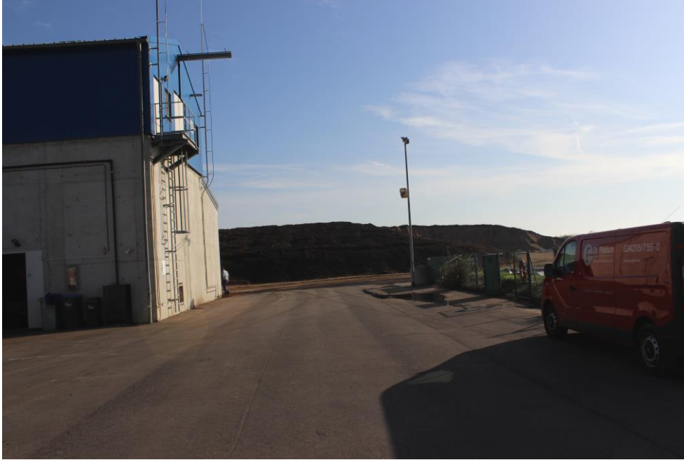
Abbildung 3: Gärsubstratmischung (Gebäude links im Bild) und im Hintergrund Schrotlagerplatz (Schrot abgedeckt mit Gärresten anstelle mit Folie); Blickrichtung Osten
