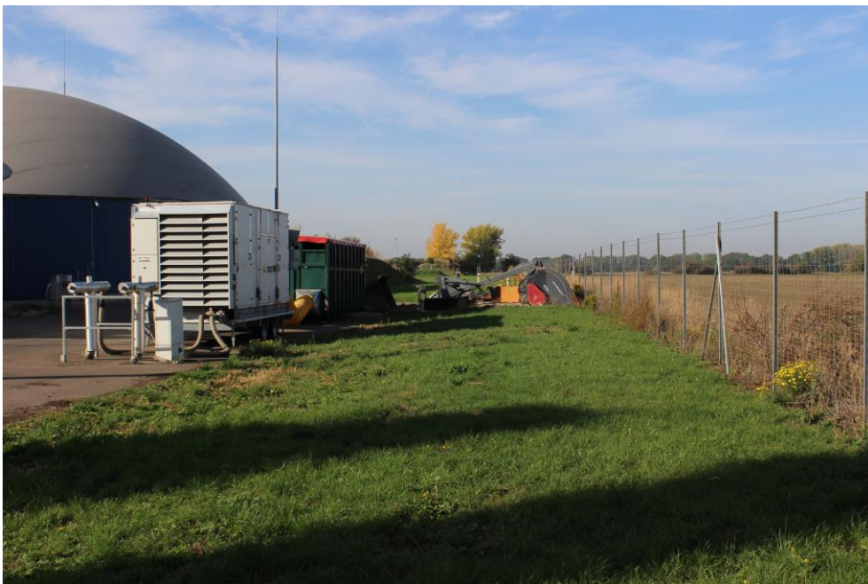
Abbildung 8: Nördlich der Gasspeicher bzw. Fermenter (Blickrichtung Westen)
