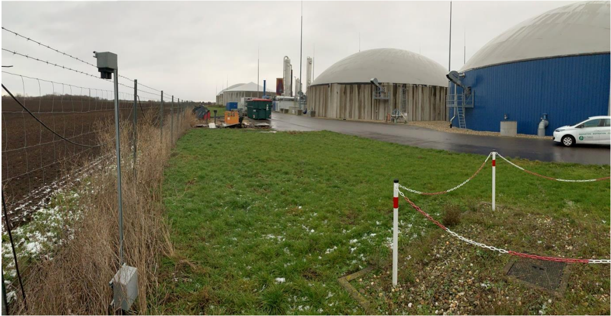
Abbildung 9: Sensor 5, Kabel am Maschendrahtzaun befestigt
