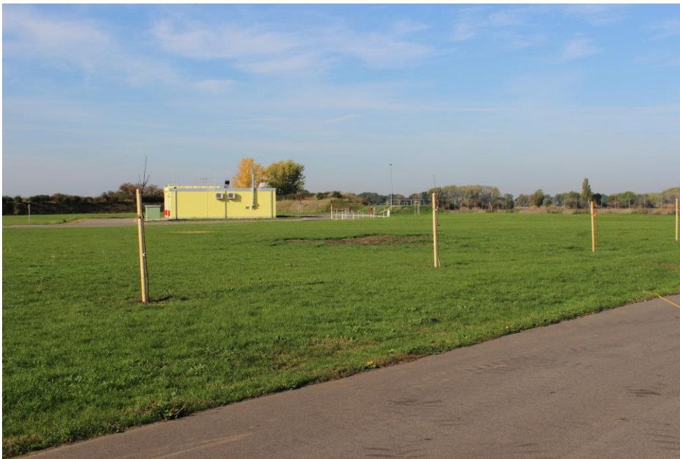
Abbildung 12: Einspeiseanlage (Blickrichtung Westen)
