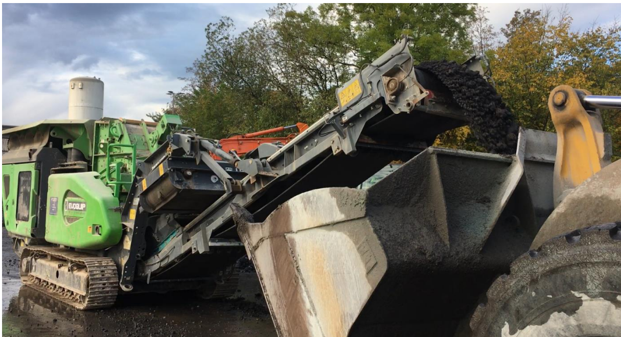
Abb. 24: Aufbereitung der behandelten EOS mittels mobiler Anlagen
