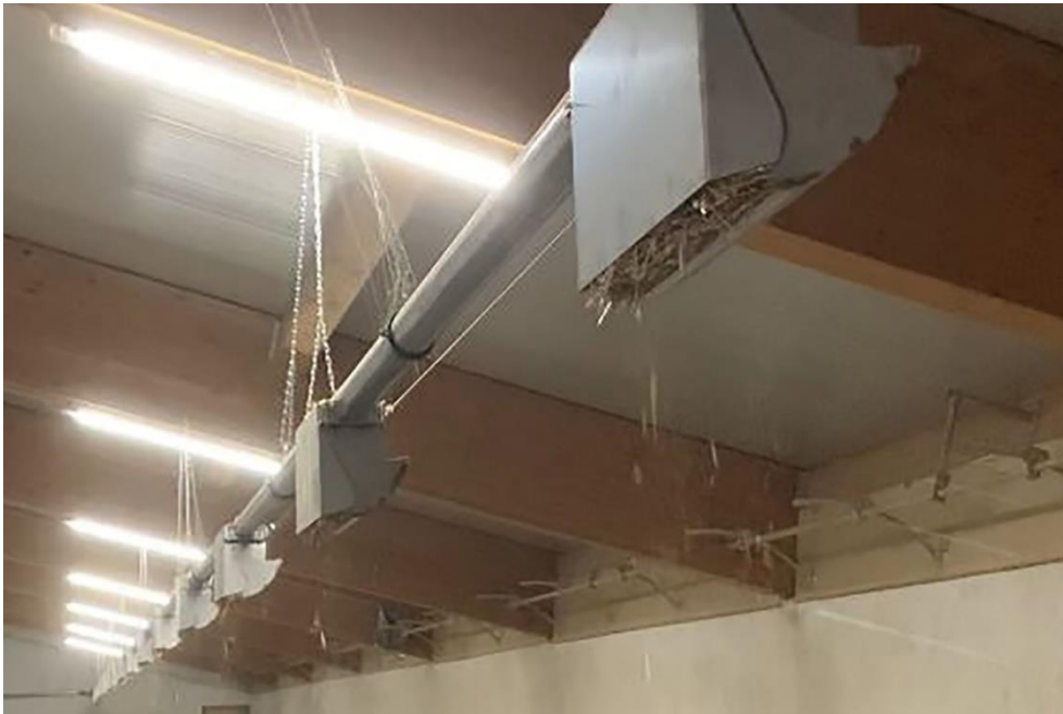
Abbildung 10: Vorratsbehälter mit Abwurfstelle für Mittellangstroh
