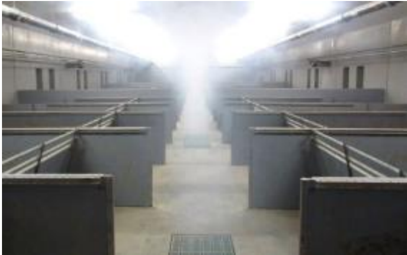
Abbildung 4: Visualisierung der Zuluftführung mittels Vernebelung
