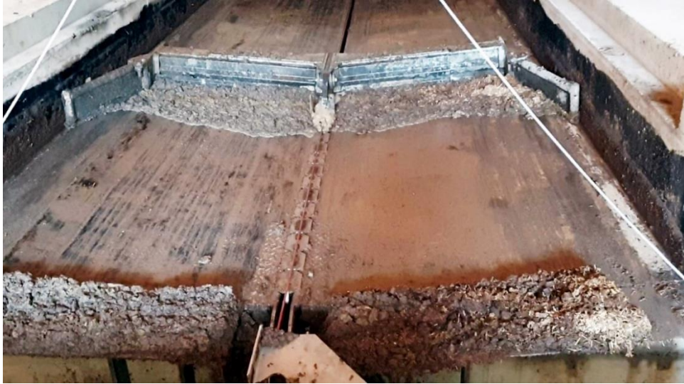
Abbildung 12: Schieberkanal mit Beschichtung und mittig vor dem Kotschieber abgedeckter Urinrinne
