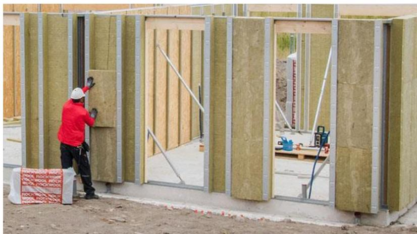
Abbildung 18: Aufbau von einem Rockzero Wandsystem
