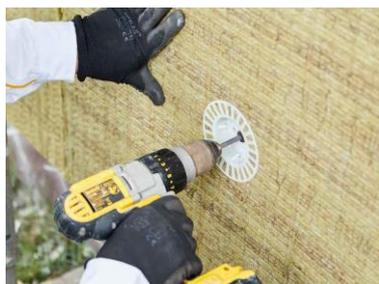
Abbildung 11: Montage der Dämmplatten mittels versenkbarer Schraubdübel
