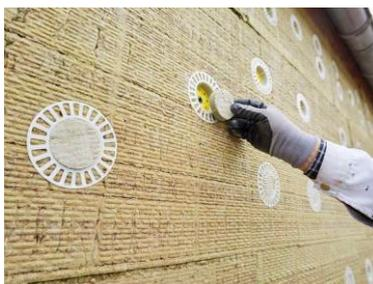
Abbildung 12: Durch Dübelrondele wird der Wärmeverlust verhindert.
