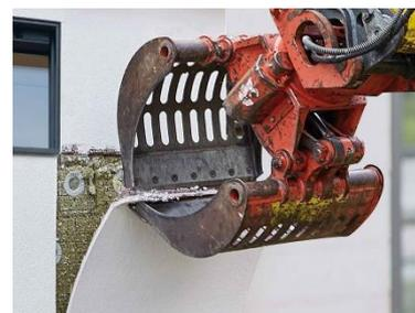
Abbildung 13: Beim Rückbau lässt sich der Putz, der in kleine Felder unterteilt ist, mit einem Bagger von der Dämmschicht lösen
