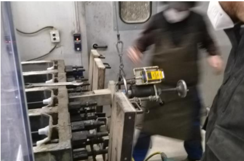
Bild 71: Kontrolle der Vorspannkraft
