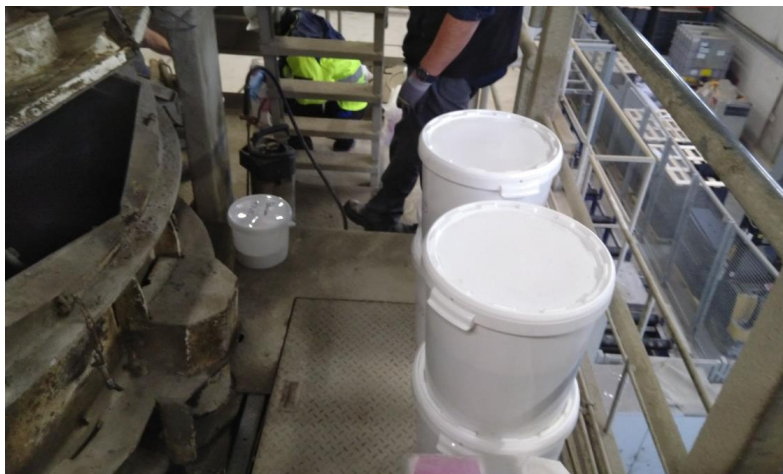
Bild 72: Manuelles Einfüllen des in Plastikeimern angelieferten Zements in die Mischanlage
