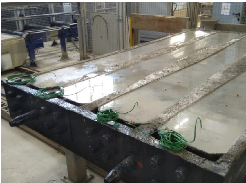
Bild 76: Form mit 4 Betonschwellen mit für die Nachbehandlung aufgebrachtem Wasser und Thermosensoren
