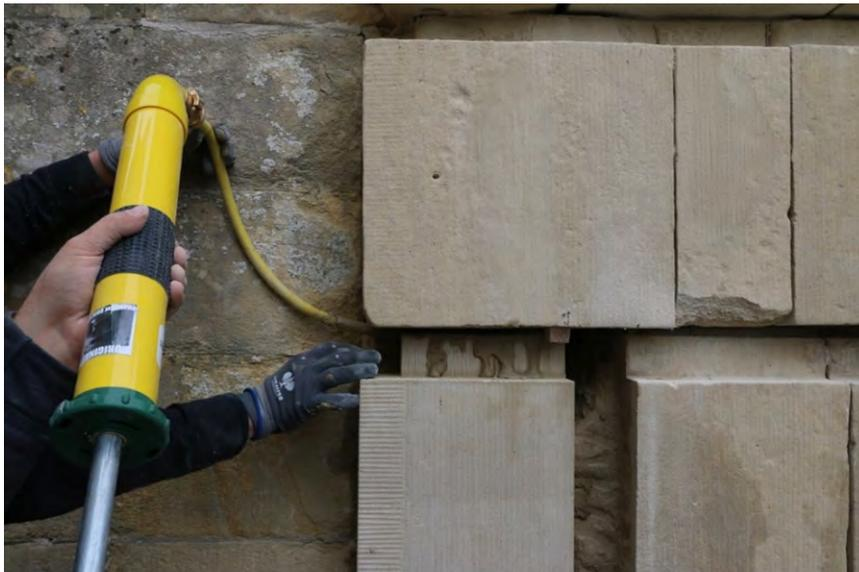
**Abb. 144:** Verfüllung der Hohlräume hinter einem Quader mit einem Kalkmörtel.
