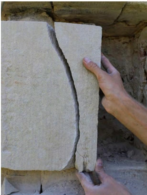
**Abb. 142:** Bruchstück wird angepasst und anschließend geklebt.
