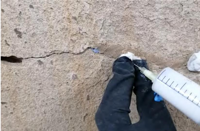
**Abb. 141:** Applikation des Rissinjektionsmörtel.
