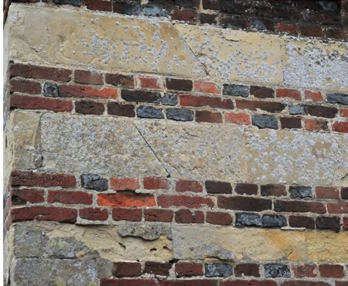
**Abb. 32:** Detail der Westfassade mit Bänderung aus Baumberger Kalksandstein.
