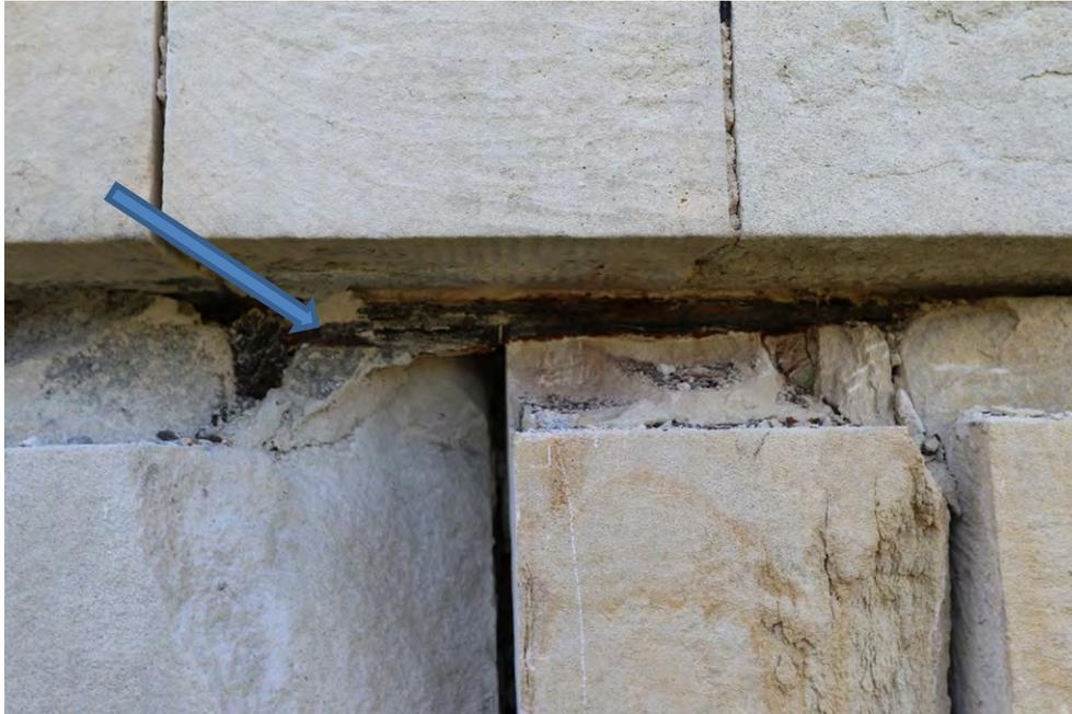
**Abb. 136:** Rostige Dübel in den Fugen wurden entfernt.
