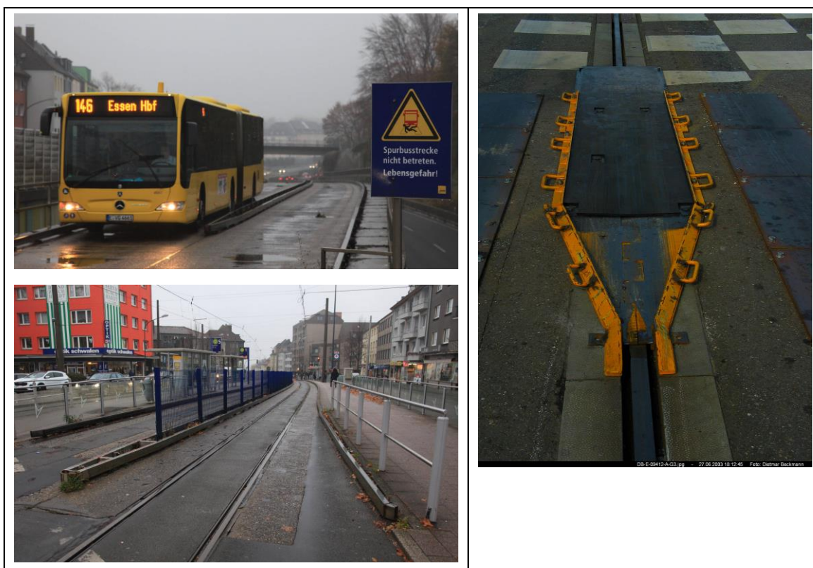
Abbildung 52: Trichterförmige Einfädelung bei den mechanischen Spurführungssystemen: Wechsel von Handlenkung auf Spurführung beim Spurbus in Essen (links) und beim Tramway in Nancy (rechts)
