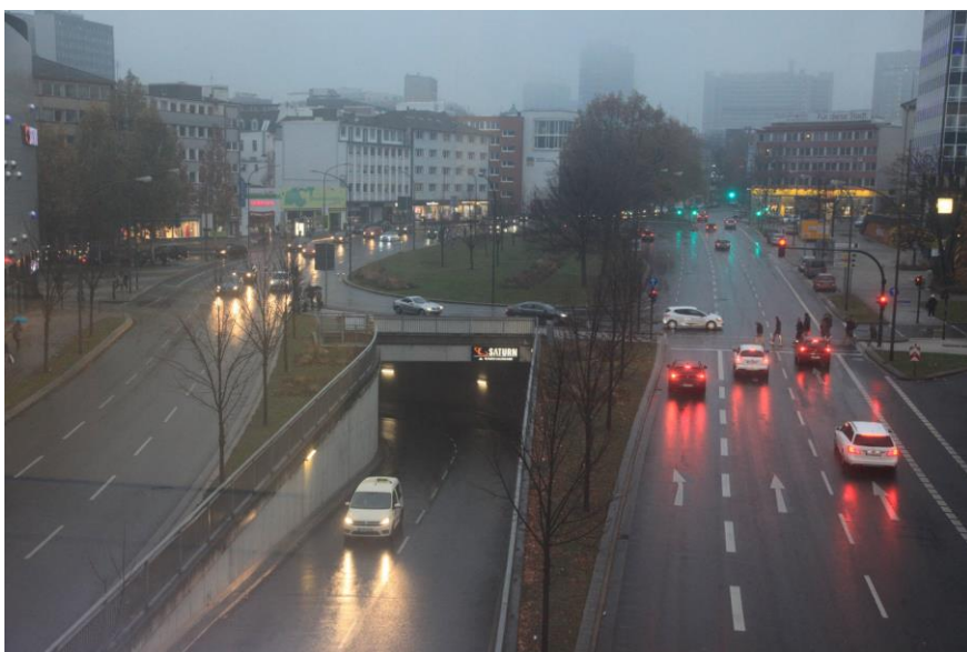
Abbildung 49: Rampe zum unterirdischen Anliefer- und Abholbereich des Einkaufszentrums Limbecker Platz in Essen
