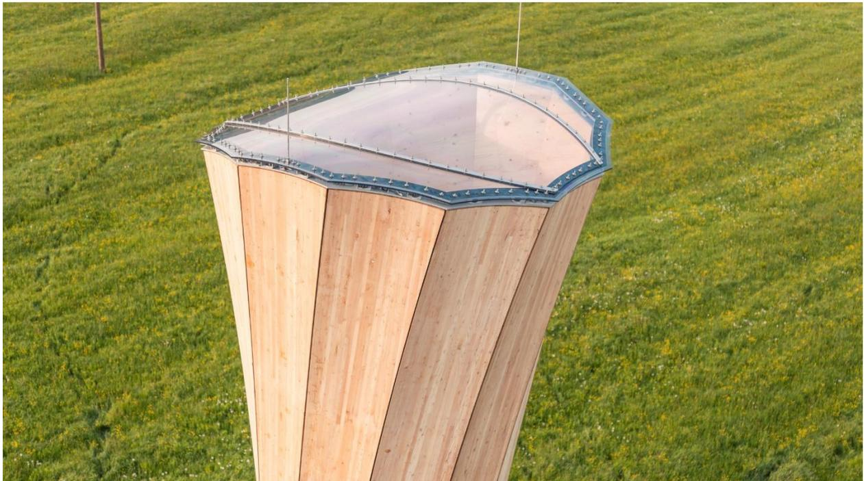
**Abbildung 34. Transparente Dachkonstruktion und Ausrichtungsring aus Stahl**
