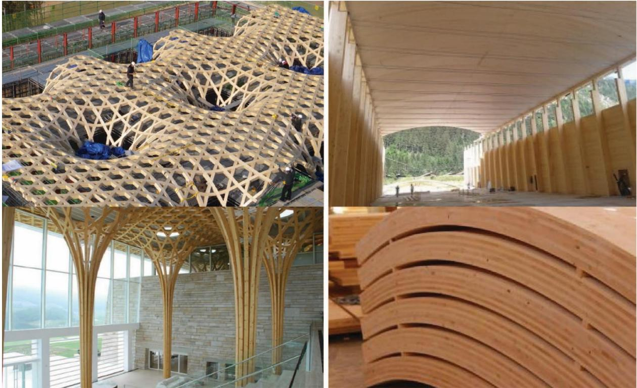
**Abbildung 7. - Gekrümmte Holzstrukturen. Links: Komplex geformte Holzbalken für gekrümmte Lamellenkonstruktion (links), (Haesley - Nine Bridges Golf Club House, Shigeru Ban Architects, 2010, Bild: Blumer Lehmann AG). Gekrümmte BSPH-Dachkonstruktion (rechts) (Holzbau Unterrainer, 2017, Bild: Holzbau Unterrainer).**
