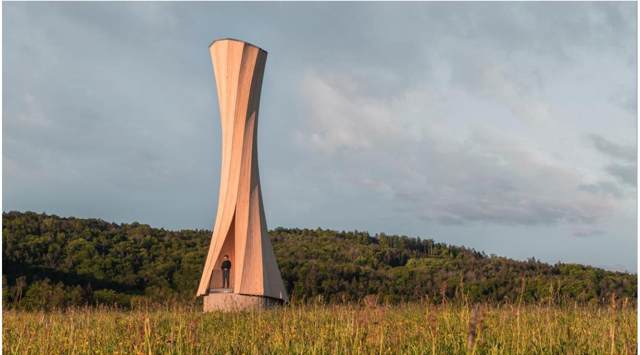
**Abbildung 42. Der Urbach Turm: Eine 14 m hohe, leichte Turmstruktur aus gekrümmtem, selbstgeformtem Brettsper Holz.**
