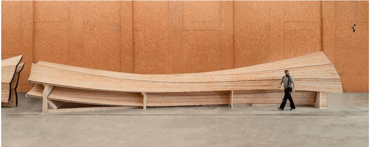
**Abbildung 31.** Fertigestellte, zu Transportgruppen vormontierte Komponenten, an denen die schützende Lärchenholzfassade angebracht ist.
