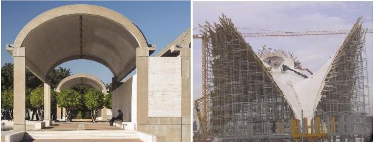
**Abbildung 4: Beispiele für zylindrische Schalenkonstruktionen aus Stahlbeton. Trotz ihrer leistungsfähigen gekrümmten Geometrie sind sie schwer und erfordern umfangreiche Schalungen, die oft aus Holz für den Fertigteil- oder Ortbetonbau hergestellt werden. Das Kimbell Art Museum, Fort Worth, Texas (links) (Luis Kahn, 1972. Bild: Kimbell Art Museum). Das Oceanogràfic in Valencia, Spanien (rechts) (Felix Candela, 2001. Bild A. Tomás).**
