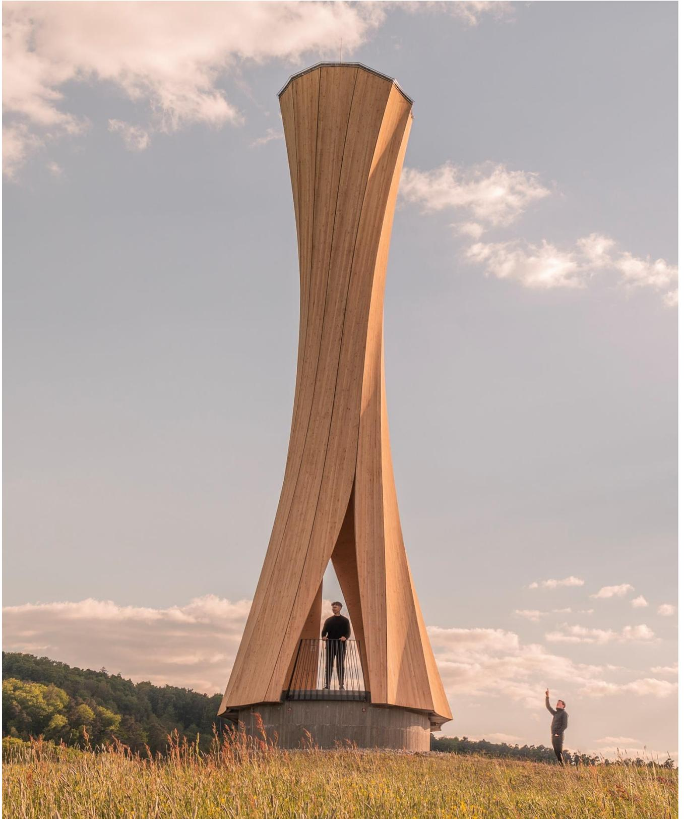
**Abbildung 1. Der Turm Urbach, eine hochleistungsfähige Holzkonstruktion aus nachhaltiger und ressourcenschonender Herstellung von gekrümmtem Brettsperrholz (ICD / ITKE - Universität Stuttgart)**
