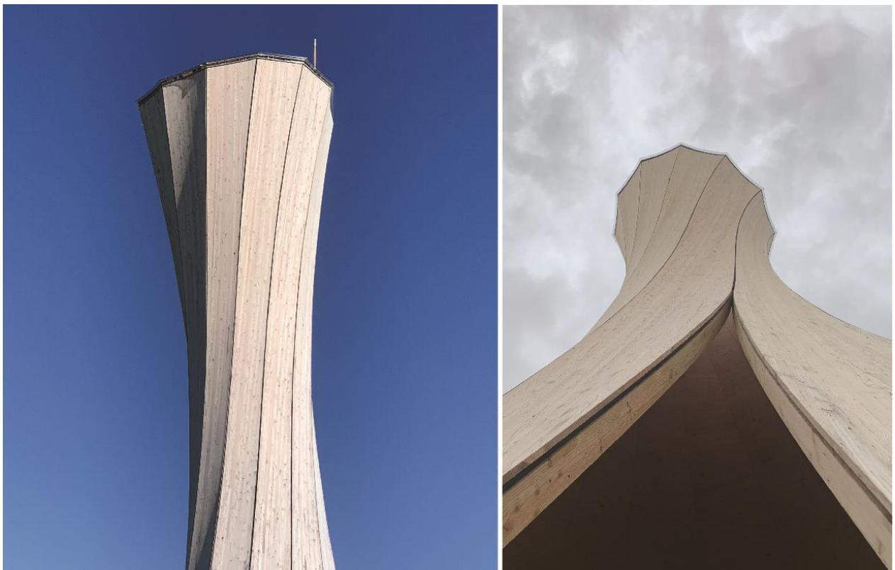
Abbildung 33. Lärchenholzfassade mit transparenter UV-Holz-Oberflächenbehandlung nach 9 Monaten Bewitterung. Die Bewitterung ist an den unteren Bereichen der Konstruktion sichtbar, wo die Oberfläche weniger stark vertikal wird (links).
