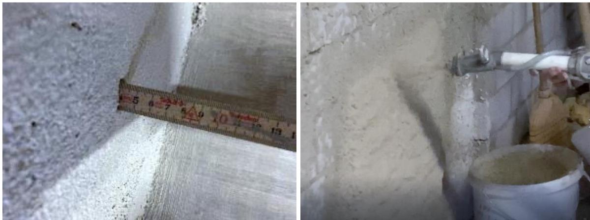
Abbildung 3-12: Sumfoam als Dämmputzsystem in der Praxisanwendung. Links: Schichtdicken von wenigen Zentimetern bestätigen den positiven Effekt von Sumfoam und können durch mit aufwendigen Wärmeverbundsysteme konkurrieren. Rechts: Die Anwendung von Sumfoam-Dämmputz zeichnet sich durch einfaches Handling und ohne Modifizierung innerhalb der Anwendung mit gängigen Putzmaschinen aus.
