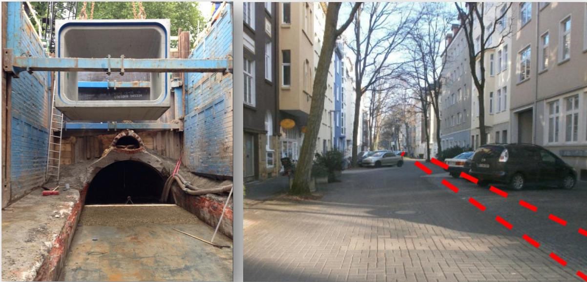
**Abb. 2, 3:** Links: Der marode Lutter-Kanal unten und der Beginn der Sanierungsarbeiten im BA II (Quelle: Umweltbetrieb Stadt Bielefeld); rechts: Erste Überlegungen zur Gewässerführung in der urban geprägten Ravensberger Straße (Quelle: ZPP Ingenieure GmbH, Köln)
