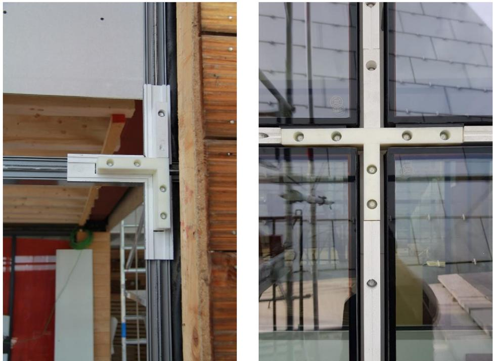
**Abbildung 4:** Ertüchtigung der Bestands-PR-Fassade mit dem eigens entwickeltem Aufdopplungsprofil der Fa. ENERsign
