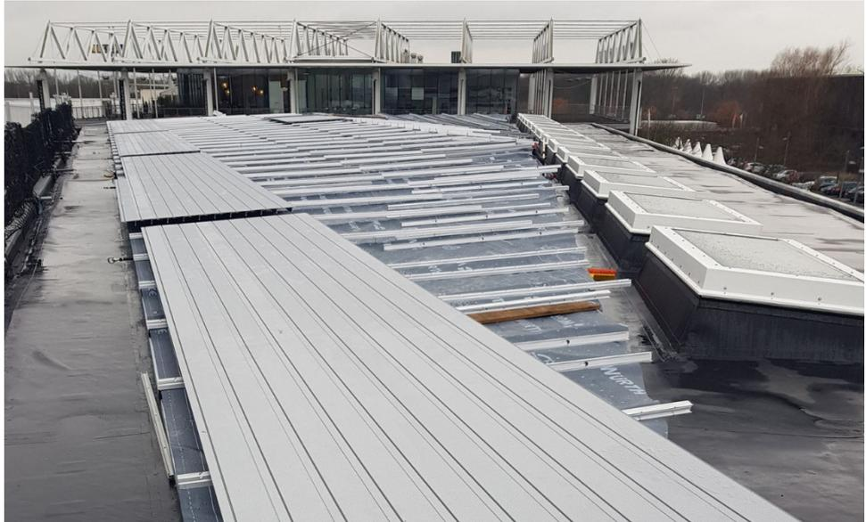
**Abbildung 9: Dachaufsicht nach Installation von Tragschienen und Wärmeübertragerprofilen**
