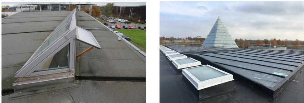
**Abbildung 5:** Dachaufsicht links vor der Sanierung, rechts nach der Sanierung und Fertigstellung der PVT-Dachunterkonstruktion
