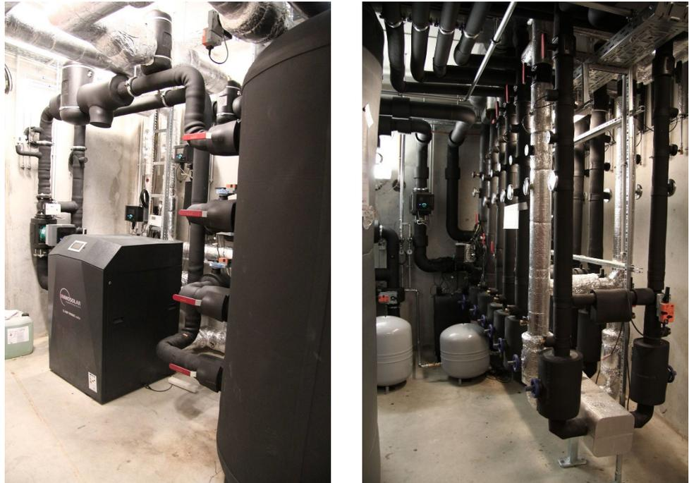
Abbildung 7: Technikkeller, links: Wärmepumpe und Kälte-/Quellenspeicher, rechts: Heiz- und Kühlverteiler
