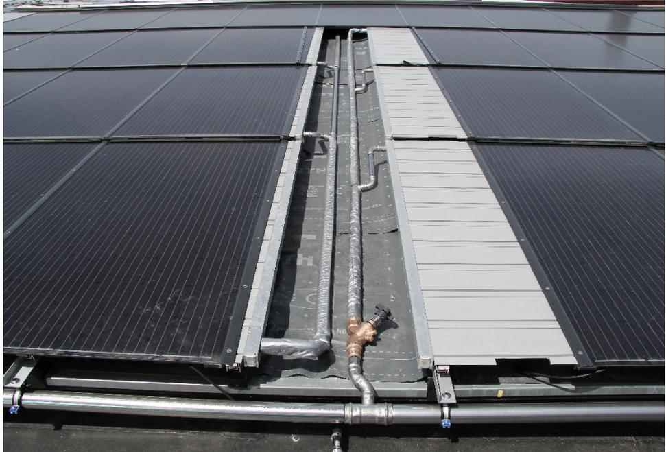
Abbildung 10: Hydraulische Anbindung der PVT Felder, Hydraulischer Abgleich mit Strangregulierventilen
