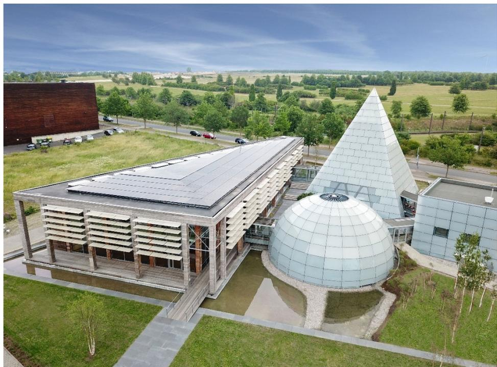
Abbildung 8: Sanierter Dänischer Pavillon mit Indach-PVT-Kollektoren
