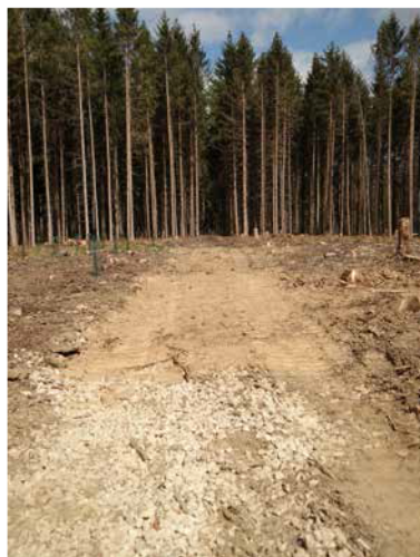
Abb. 23 Wiederherstellung der technischen Befahrbarkeit einer Rückegasse in einem Unkengebiet durch Schroppen mit Lehmauflage. Die Gasse wurde im Untergrund mit Schroppen befestigt (linkes Bild) und anschließend mit einer Lehmauflage abgedeckt (mittleres Bild). Im Zuge der nächsten Holzernte entstanden hier Fahrspurgewässer (rechtes Bild) mit erfolgreicher Reproduktion der Gelbbauchunke.
