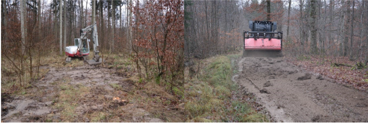
Abbildung 6) Die Sanierung von Rückegassen ist ein integraler Bestandteil in der Forstwirtschaft um Fahrspuren zu beseitigen und die langfristige technische Befahrbarkeit einer Gasse zu gewährleisten. Wir plädieren jedoch für eine zeitverzögerte Sanierung entstandener Pfützen im Folgejahr nach ihrer Entstehung. Für die Gelbbauchunke ist dieses Management ideal, da dies die Dynamik, Trockenpause und fortlaufende Entstehung „frischer“ Kleinstgewässer sicherstellt. Im Projekt haben sich Sanierungen mit Baggern (linkes Bild) und Forstmulchern (rechtes Bild) gleichermaßen bewährt. (Fotos: F. Schrell)
