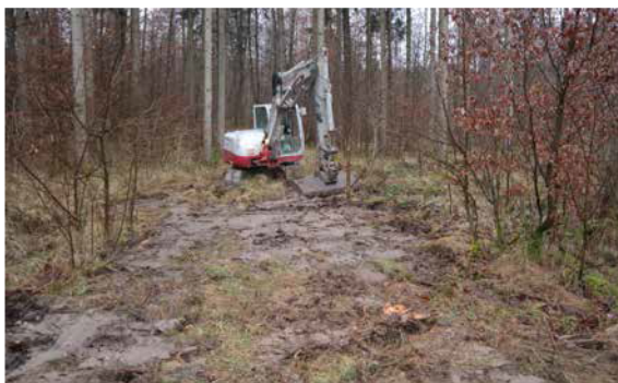
Abb. 26 Kürzere Gassenabschnitte mit tieferen Fahrspurgewässern können problemlos mit einem Bagger eingeebnet und saniert werden. Eine Sanierung von alten wassergefüllten Fahrspuren sollte im Herbst/Winter erfolgen. Die eingeebnete Gasse bietet Möglichkeiten für die Entstehung neuer Kleinstgewässer bei der nächsten Durchfahrung.
