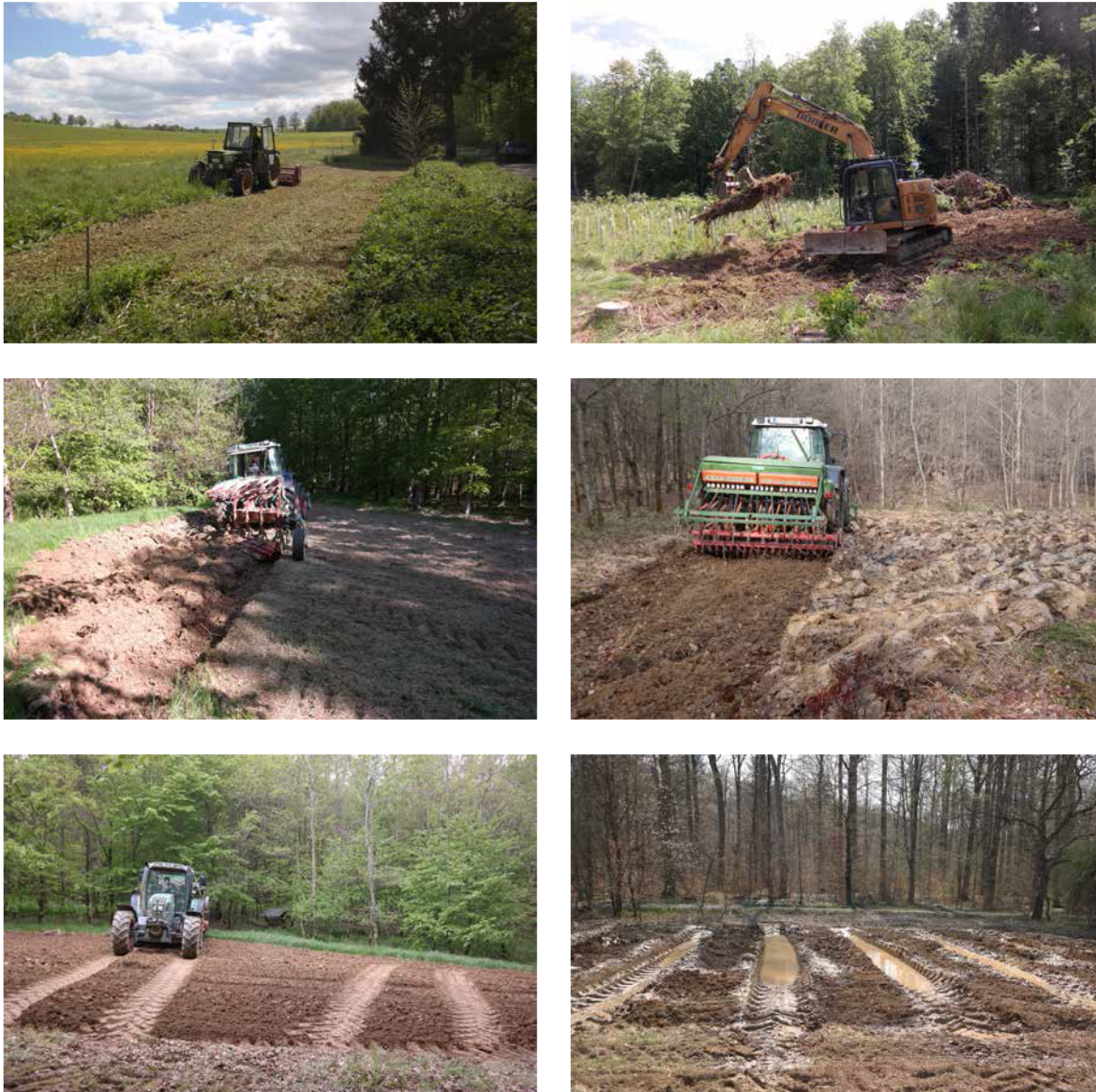
Abb. 29 Schritte zur Anlage eines Wildackers / einer Dynamisierungsfläche: Je nach Ausgangslage wird die Fläche entweder zunächst gemulcht (Bild oben links) oder, sofern bei Ersteinrichtung erforderlich, von Wurzelstümpfen befreit (Bild oben rechts). Anschließend wird die Fläche gepflügt (Bild Mitte links) und gegrubbert (Bild Mitte rechts). Die Schritte der Bodenbearbeitung können bei erstmaliger Anlage mit Entfernung von Wurzelstümpfen ggf. entfallen. Letztlich folgt bei ausreichend nasser Witterung die Fahrspuranlage durch mehrmaliges Befahren (ca. 15- bis 20-mal pro Spur) der Spuren mit schwerem Gerät (Bild unten links), sodass ausreichend tiefe Fahrspurgewässer entstehen (Bild unten rechts).
