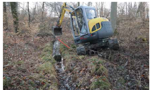
Abb. 26 Kürzere Gassenabschnitte mit tieferen Fahrspurgewässern können problemlos mit einem Bagger eingeebnet und saniert werden. Eine Sanierung von alten wassergefüllten Fahrspuren sollte im Herbst/Winter erfolgen. Die eingeebnete Gasse bietet Möglichkeiten für die Entstehung neuer Kleinstgewässer bei der nächsten Durchfahrung.
