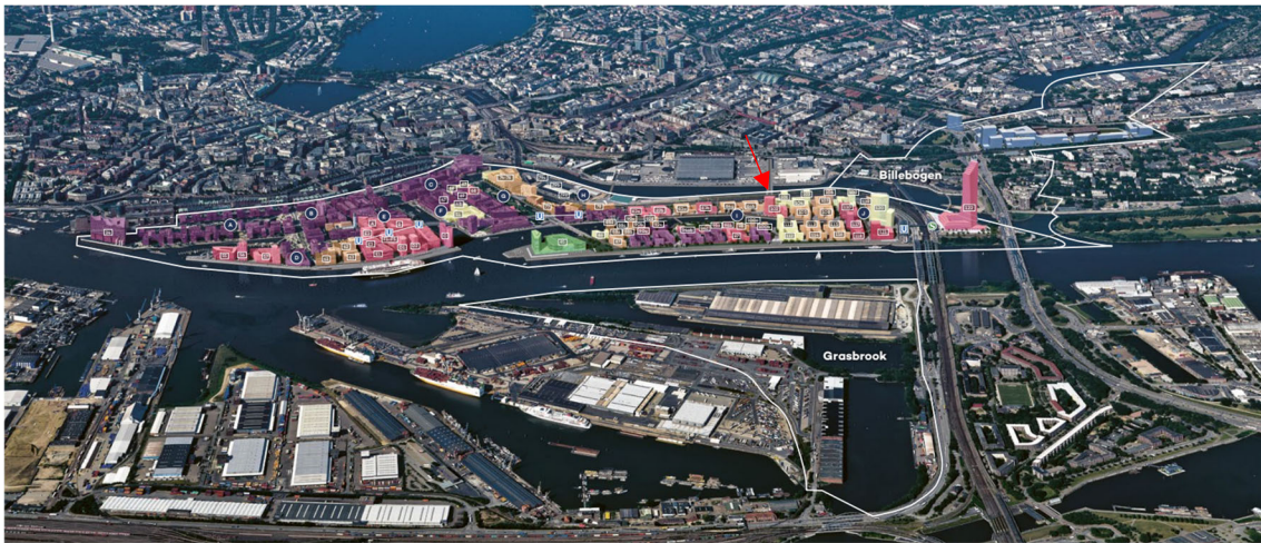
Abb. 1: Baufeldübersicht der HafenCity Hamburg (HCH, 2021)
