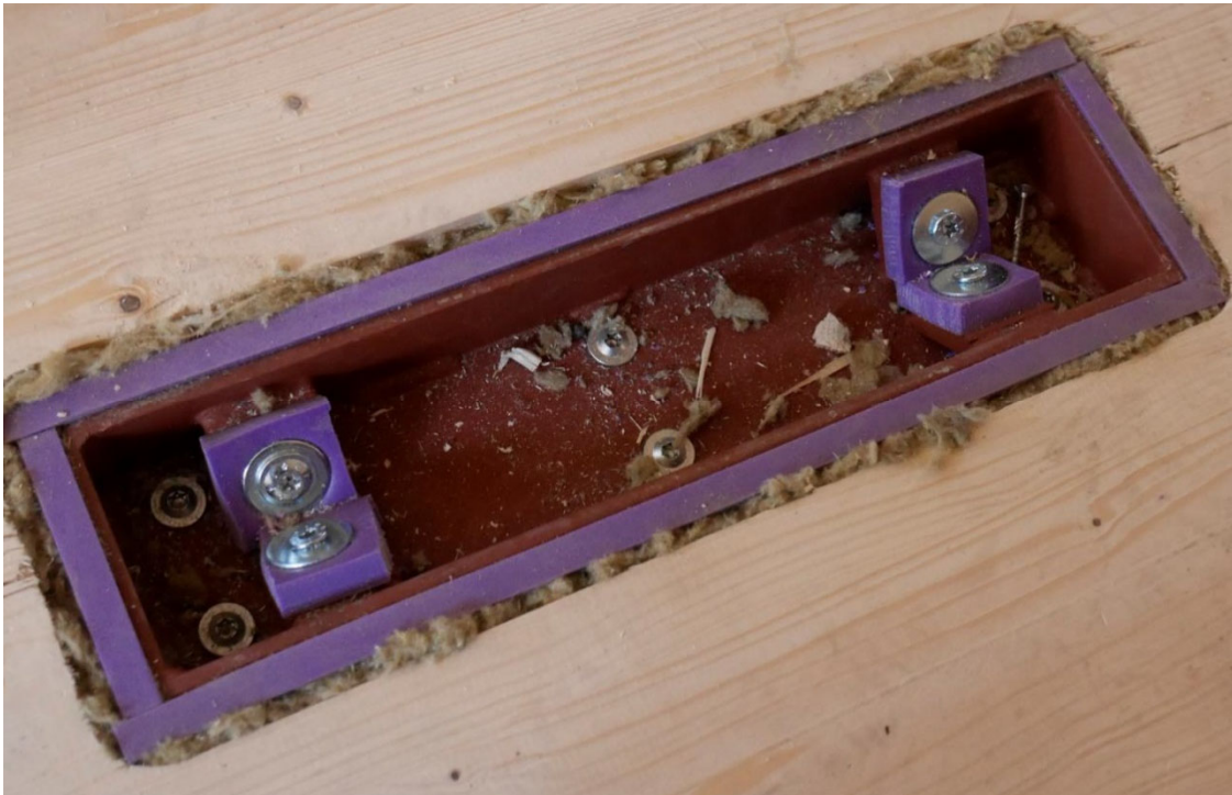
Abb. 18: Elastisch entkoppelter Deckenverbinder (Foto: ABP)
