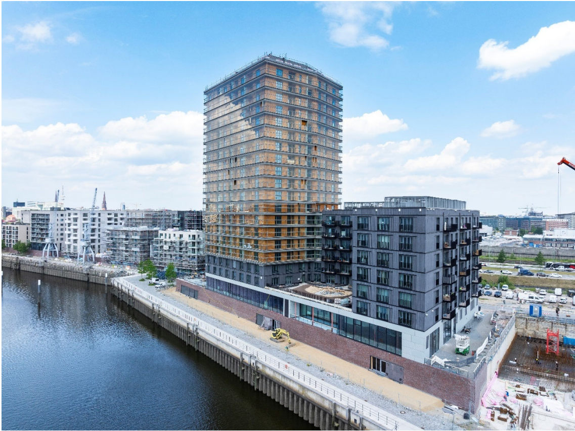
Abb. 2: Blick vom Baakenhafen nach Osten auf das roots (© Copyright – Daniel Sumesgutner / Garbe Immobilien-Projekte GmbH, 2024)
