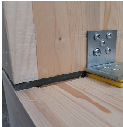
Abb. 20: Entkoppeltes Stützauflager (IFAS)
