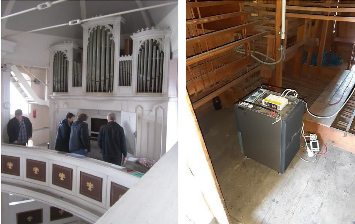
**Abb. 61** Wöllnitz, links **Ortstermin** (2016), rechts der **Raumluftentfeuchter mit dem Vorschaltgerät** für die gezielte Zuschaltung des Entfeuchtungsprozesses in der Orgel (2020)
