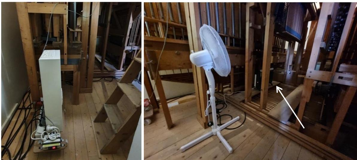
Abb. 49 links: mobile Anschluss- und Regeleinheit, rechts: mobiler Lüfter und Elektroheizkörper
