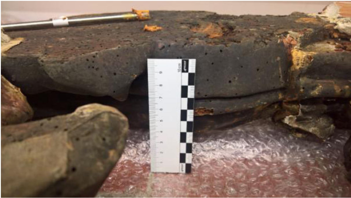
Abb. 60: Engel, Dreifaltigkeitskirche, Görlitz, Bohrkernentnahme (P1-P3)
