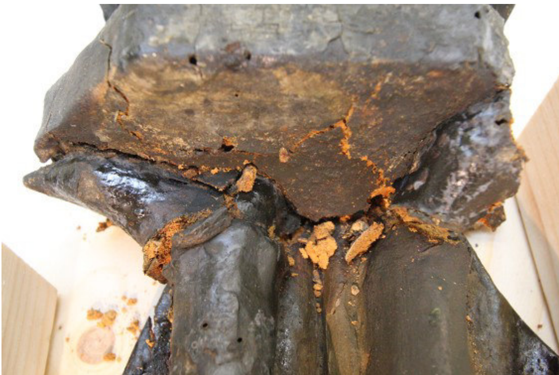
Abb. 10: Sockelbereich nach der Entölung
