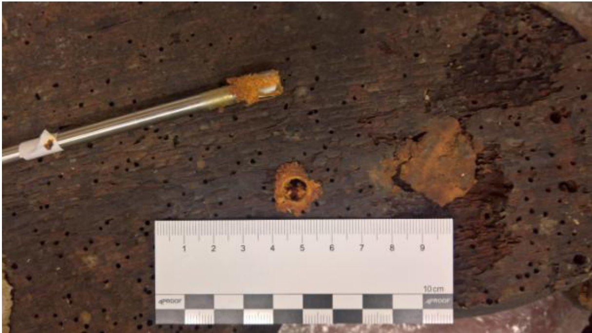
Abb. 58: Engel, Dreifaltigkeitskirche, Görlitz, Bohrkernentnahme (P1-P3)
