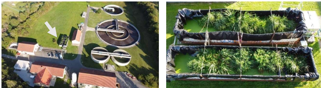
Abbildung 4: Versuchsanordnung am Kläranlagenstandort Schleiz, Thüringen I
